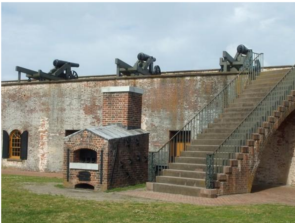
Фото В.8. Стационарна гартувальна піч (реконструкція)
