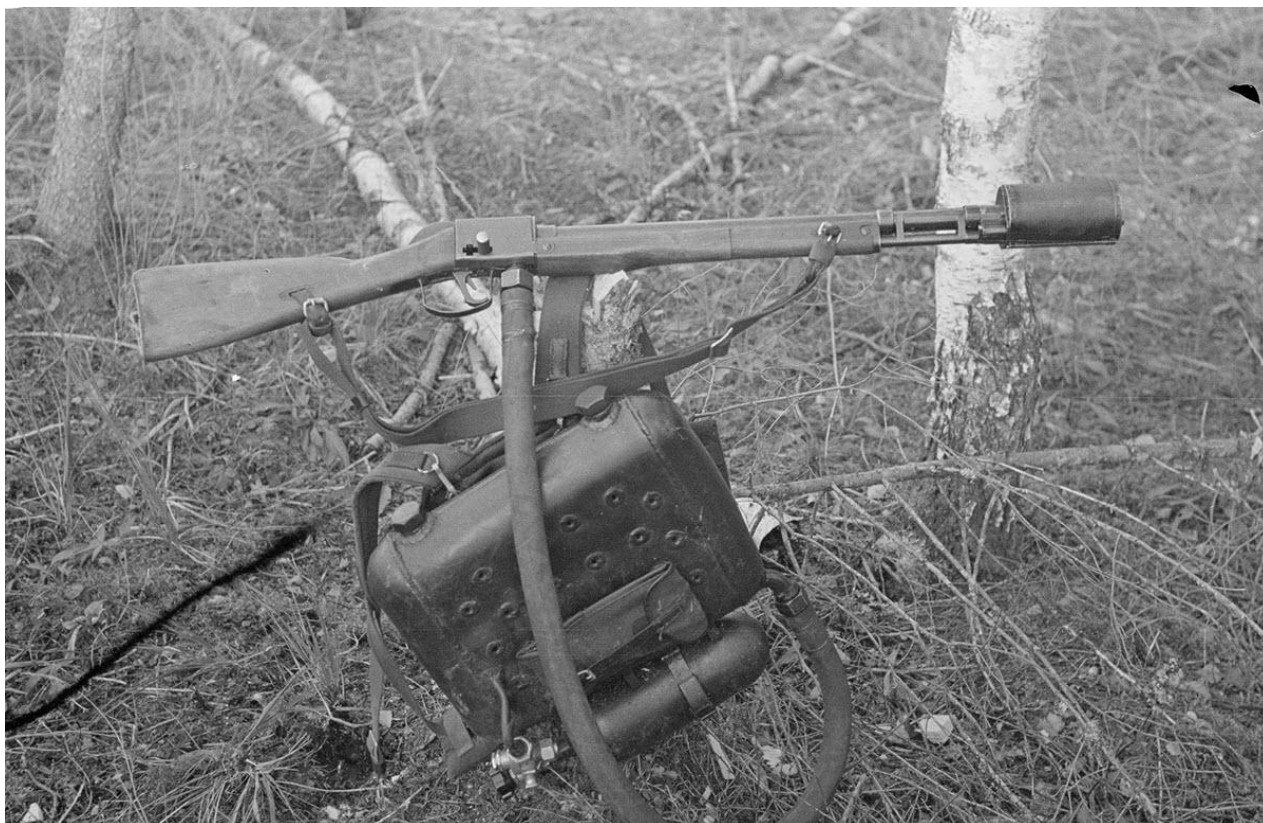
Фото Е.12. Піхотний ранцевий вогнемет РОКС-2, СРСР
