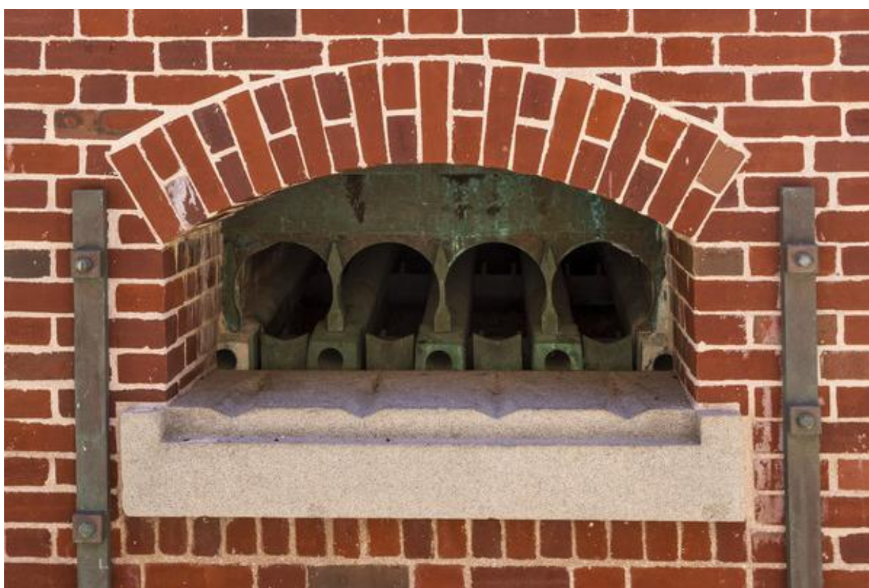
Фото В.9. Стационарна гартувальна піч (реконструкція)
