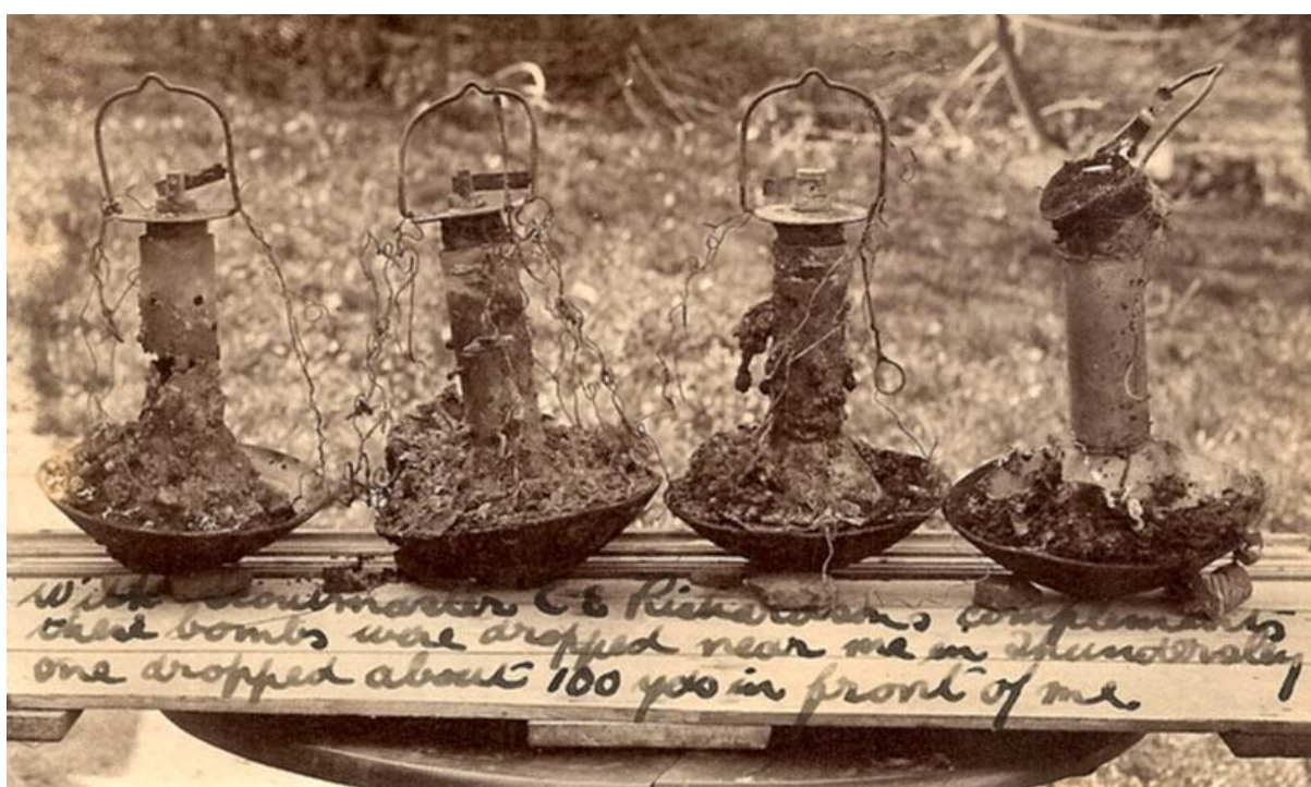
Фото Г.24. Осердя німецьких запалювальних бомб, що спрацювали у штатному режимі
