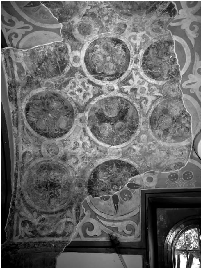
Своды юго-западной башни Софийского собора. Фрески XI в.
