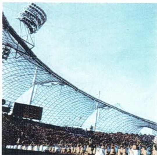
Іл. 116. Олімпійський стадіон, Мюнхен, Німеччина, інж. Ф. Отто, 1972. Тентове покриття – сітка з тросів, що покрита акриловим склом
