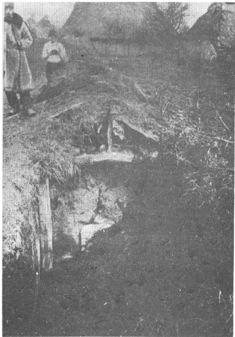
68. Горно, вигляд ззаду, унизу видно діру, через яку кладуть дрова для випалу
