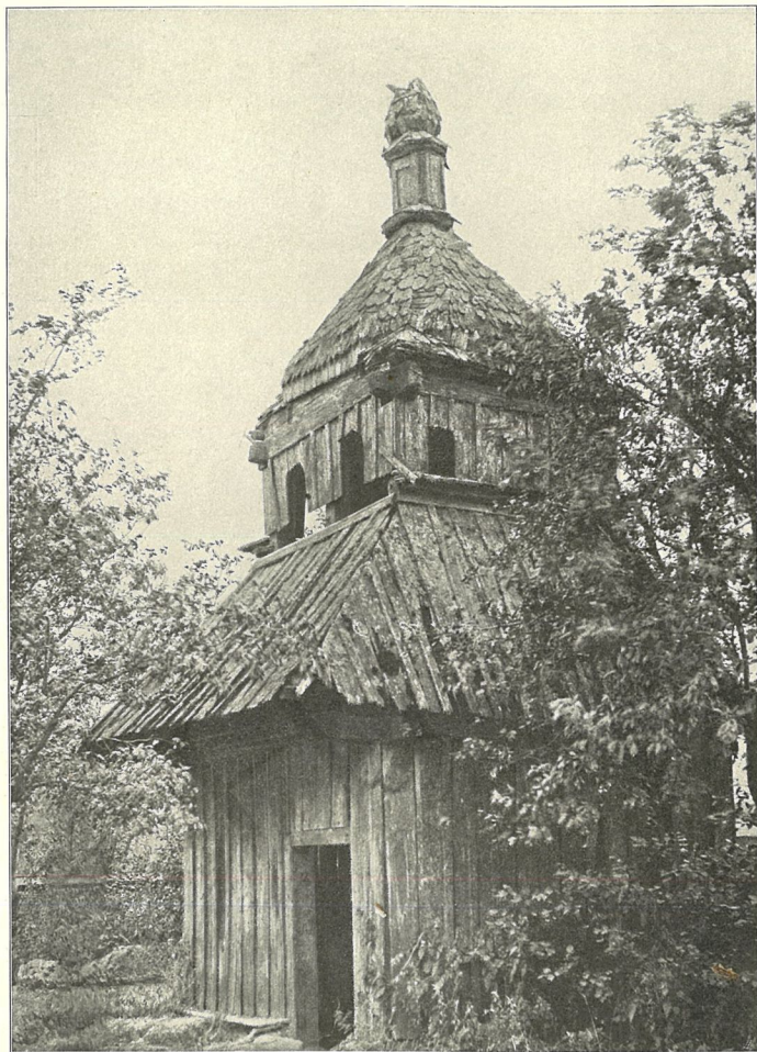
26. Звіниця XVIII віку, с. Дубровишчї, пов. Ляповець в Київщинї, (уже зруйнов.).
