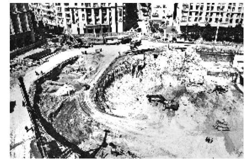
Рис. 9. Вид з півдня котловану будівництва на Майдані Незалежності. 2001 р. (фото К. Шматова)
