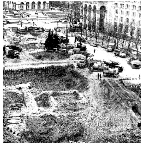
Рис. 4. Вигляд з півночі котловану будівництва на пл. Жовтневої революції із залишками цегляних фундаментів Печерських воріт XVIII ст. в центрі. 1981 р. (фото М. Сагайдака)
