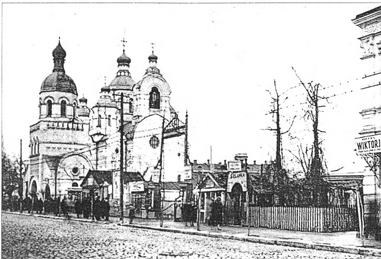
Рис. 3. Загальний вигляд дзвіниці та собору із заходу. Фото 1930-х рр. Надане В. Луцом.
