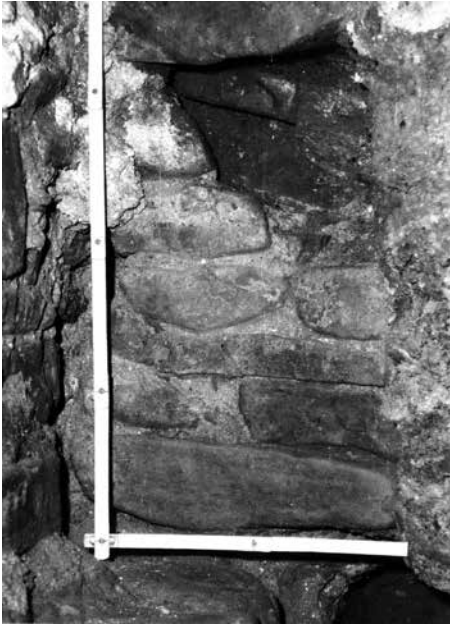
Рис. 54. Східна конха. Прикладка південно-західної лопатки. Вигляд зі сходу.
