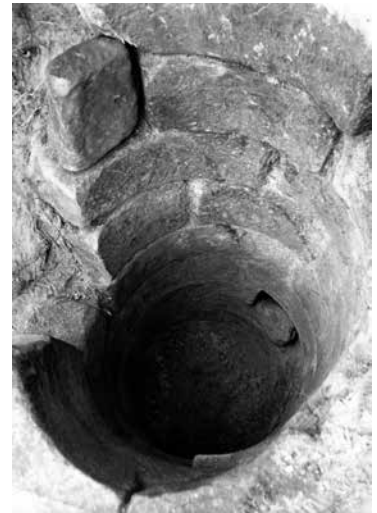
Рис. 100. Тустань. Цистерна, вимурувана з кам'яних блоків. Вигляд зверху. Фото М. Рожка.
