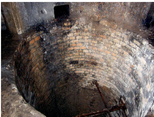
Рис. 12. Колодязь під казармою.
