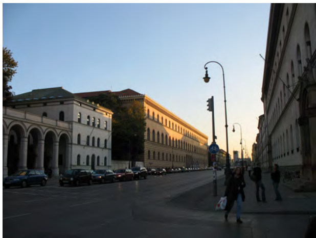
Рис. 8. Громадські будинки на вул. Людвігітрассе в Мюнхені
