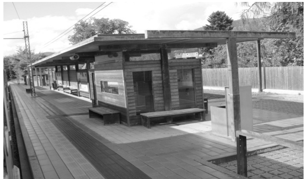
Рис. 16. Пасажирська споруда станції С. Лоренцо / Ст. Лоренцен, Південний Тироль. Фото автора
