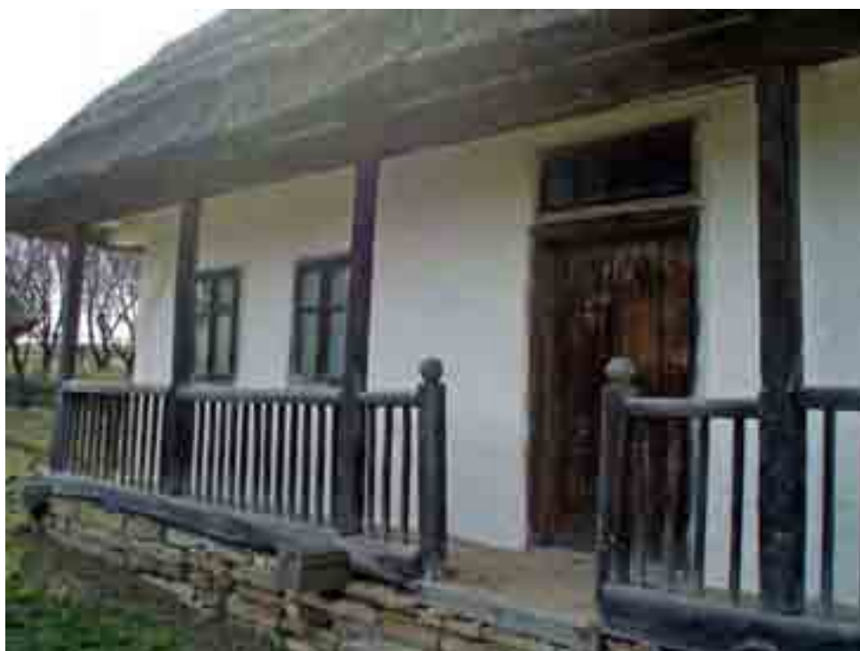
Галерея на фасаді хати.
