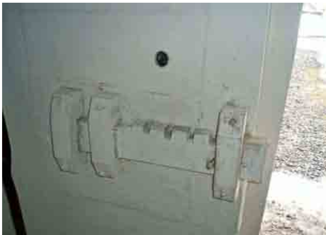
Дерев'яний засув на вхідних дверях із середини. Відчиняється довгим залізним ключем. Батьківська хата Т.Шевченка.
