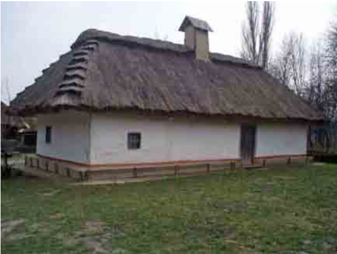
Вигляд з тильного боку
