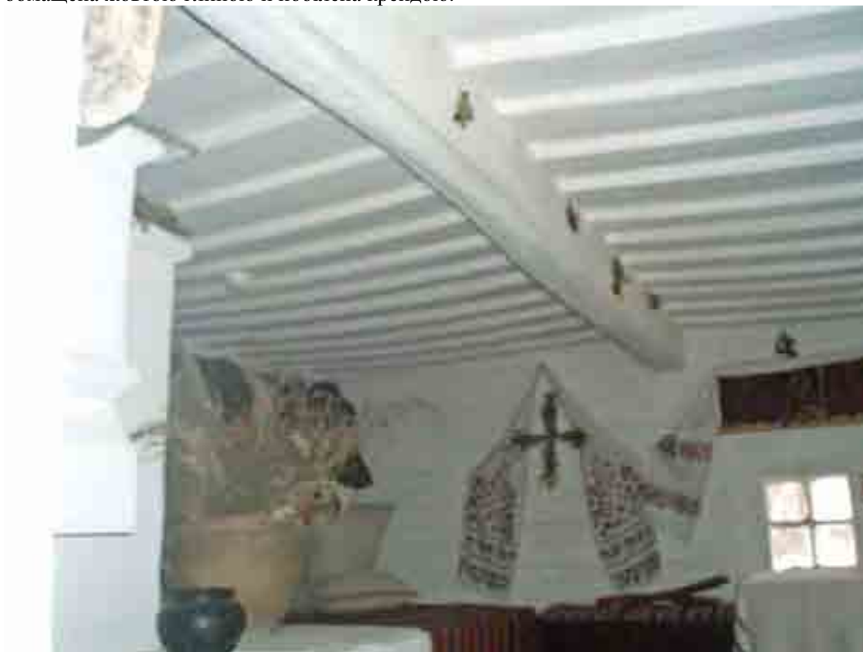
Стеля з поздовжнім сволоком. Батьківська хата Т.Шевченка.
