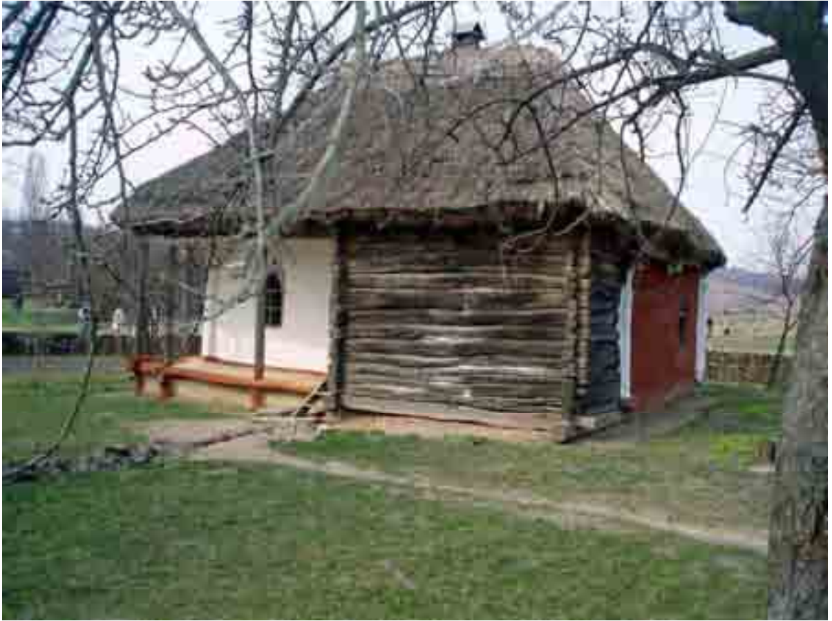
Вигляд з тильного боку.
