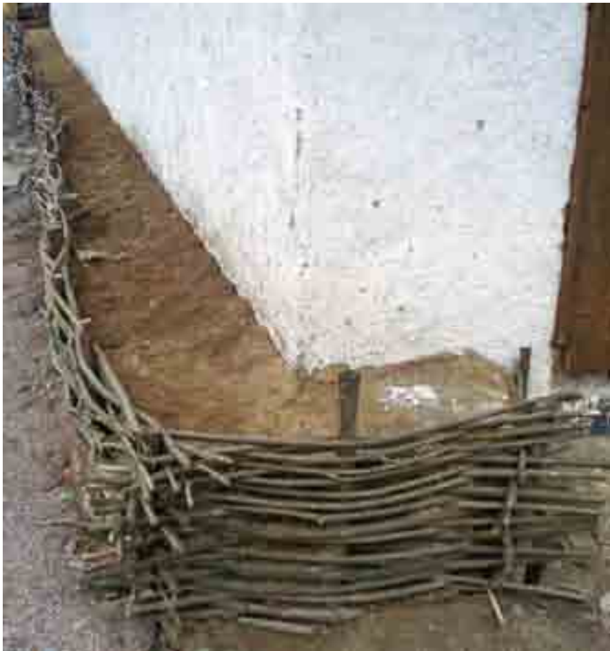
Призьба влаштована з лози й забита глиною. Запорізька Січ.
