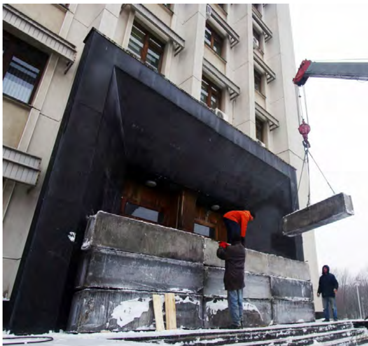
Обкладення ОДА бетонними блоками (фото mediaport.ua)
