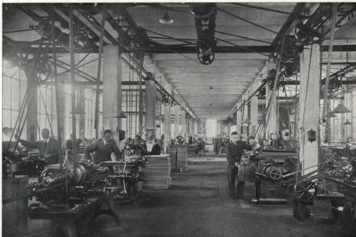
GŁÓWNA HALA FABRYCZNA
