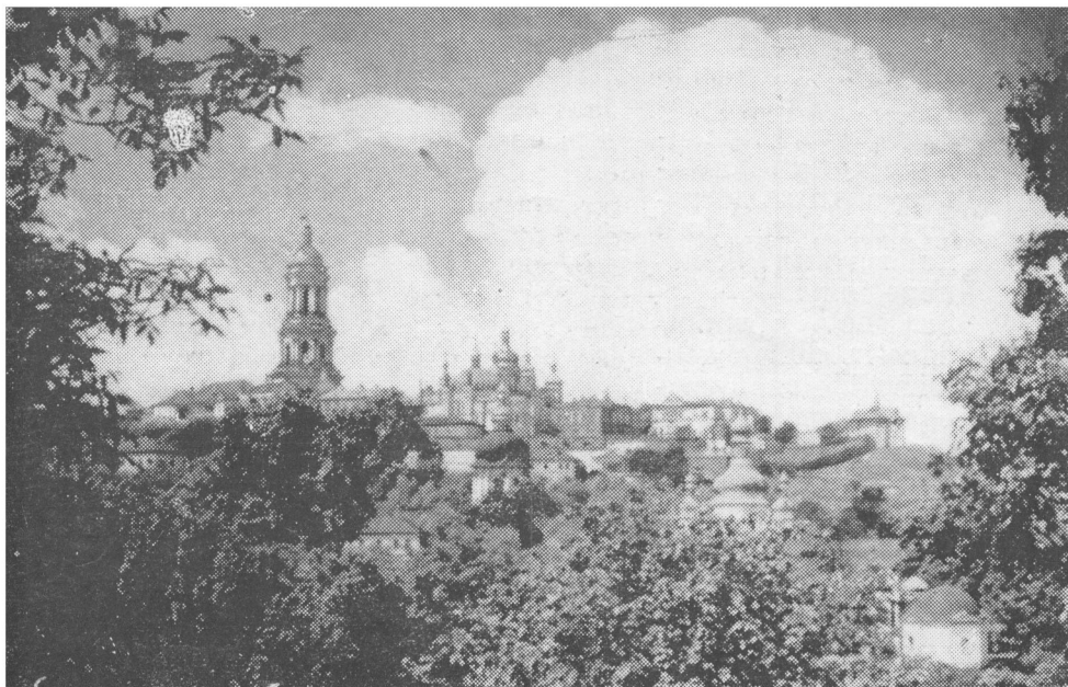
Загальний вигляд Києво-Печерської лаври з півден. боку Kiev-Pechera Monastery
