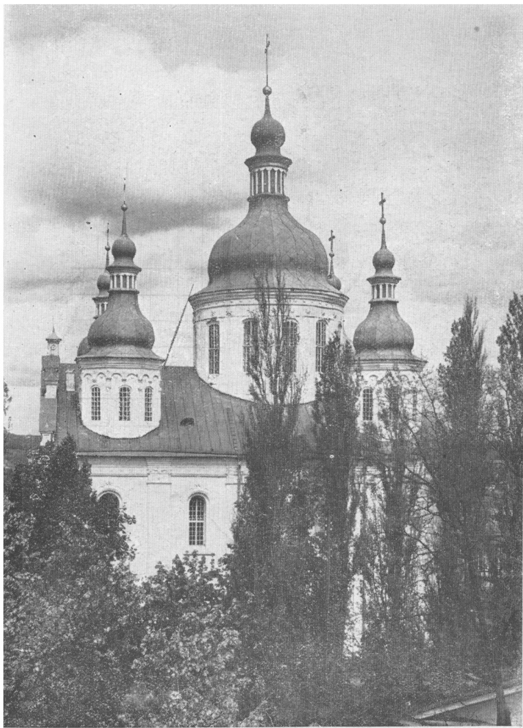
6. Кирилівська церква, споруджена князем Всеволодом Ольговичем в 1140-х рр., перебудована в XVIII ст. St. Cyril Church, erected by Duke Wsewolod Olehowych in 1140; rebuilt in the XVIII century.
