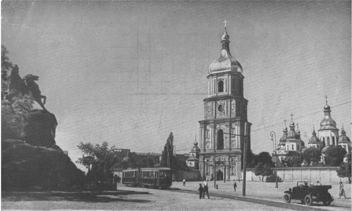
3. Софійська площа. Катедра св. Софії, споруджена великим князем Ярославом Мудрим близько 1040-х рр. Після кількох руйнувань відбудована гетьманом Ів. Мазепою в 1690-х рр. Sophia-Place. Cathedral of Holy Sophia, built by the Ukrainian Monarch Yaroslav the Wise c. 1040. Several times ruined, restored 1690 by Hetman Iwan Mazepa.
