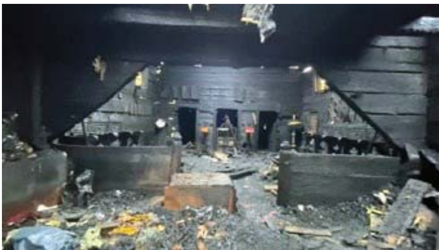
Усередині храму вигоріло все дотла. Однак основні стіни ще можна зберегти й використати у під час реставрації споруди.
