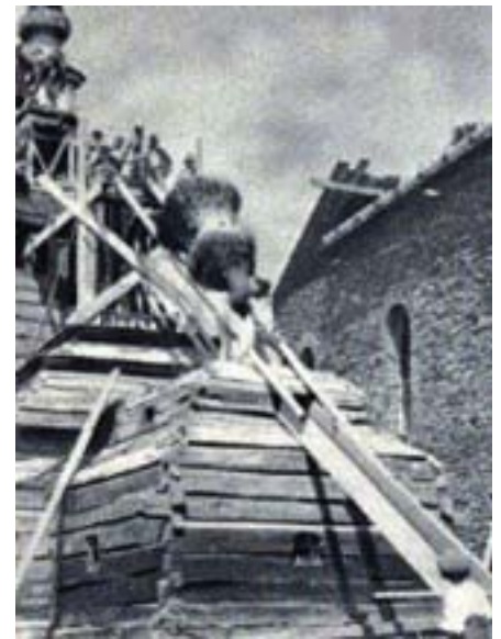
Спуск вежі. Всі елементи ретельно позначили. Фото з часопису Pestrý Týden, 1929.
