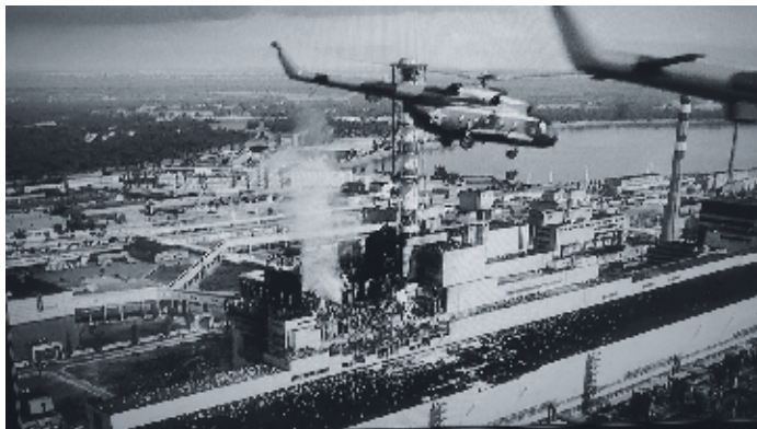
Аварія на ЧАЕС
