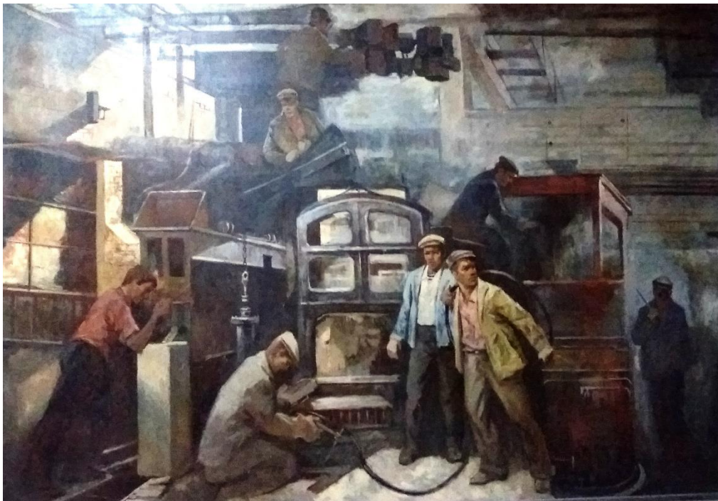
«Монтаж першої електричної печі на ДСС (ЗІС)». Худ. Дубінін В.К. Полотно, олія. 1959 р.
