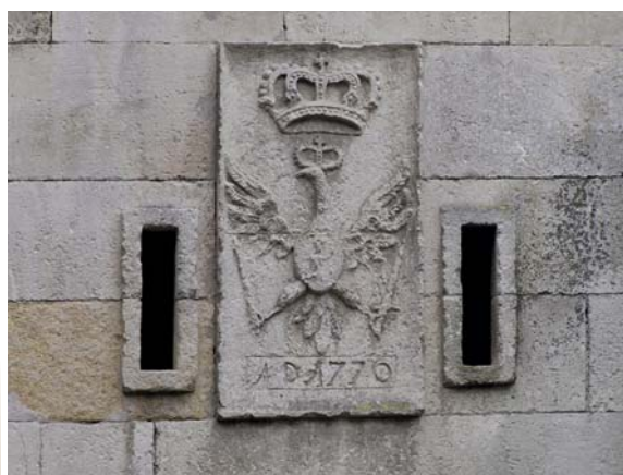
Лл. 363. Надбрамна башта Руської брами. Північний фасад. Отвори для ланцюгів герси та герб Речі Посполитої з датою реконструкції «1770». Фото О.Пламеницької
