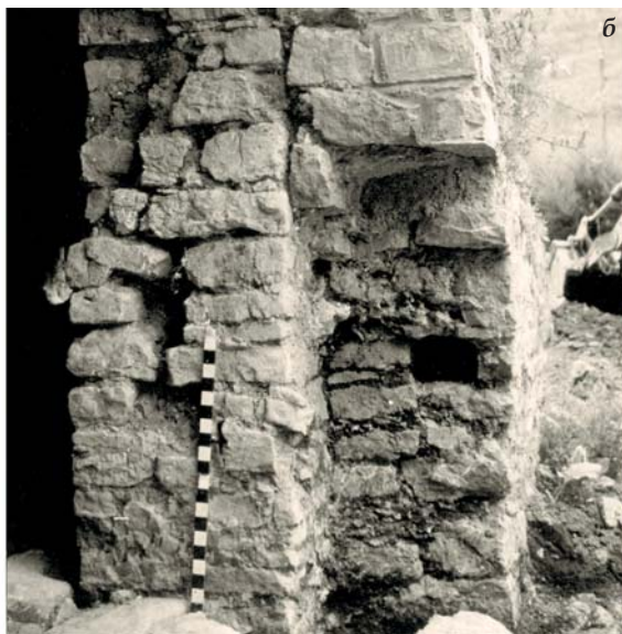
Іл. 232. Польська брама. Північна брама Надбрамної башти. Лицьова поверхня, що саморозкрилась на західному косяку брами: а – вигляд з півночі, б – вигляд зі сходу (фото Є.Пламеницької); в – паз для герси у південній брамі Надбрамної башти. Фото О.Пламеницької
