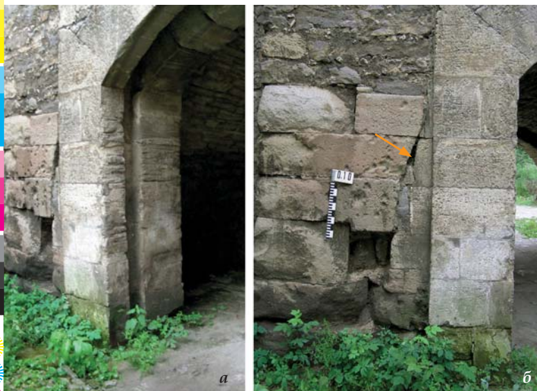
Лл. 362. а) Паз герси Надбрамної башти Руської брами; б) фрагмент арки первісної брами Надбрамної башти (показаний стрілкою). Фото О.Пламеницької
