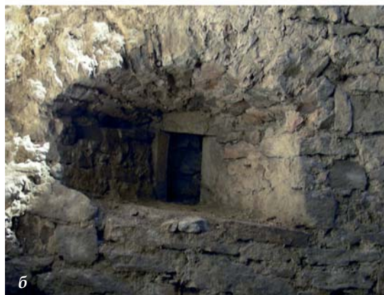
Іл. 386. Башта Стефана Баторія. Інтер'єр: а) бійниця 1585 р. на III ярусі давнього східного фасаду, що опинився в інтер'єрі східного крила 1785 р.; б) бійниця I ярусу північної стіни об'єму 1565 р.; в) фрагмент східної стіни об'єму 1585 р., в межах якої замуровано вихід у машикуль III ярусу.
