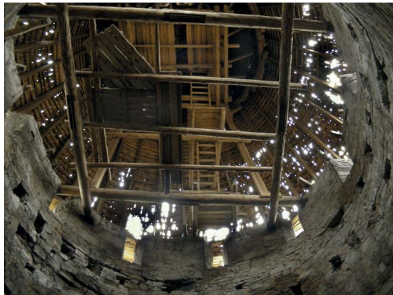
Лл. 287. Башта Різницька. Інтер'єр. Бійниці та гнізда від балок перекриття верхнього бойового ярусу. Фото А.Ізотова
