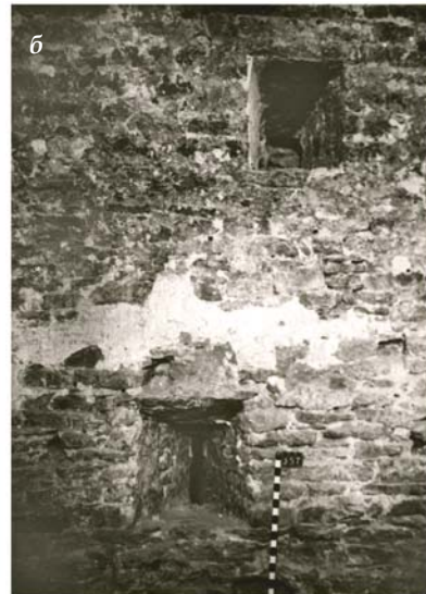
Лл. 67. Старий замок. Фрагмент стародавнього західного муру протозамку в межах башти Денної: а – план, переріз (дослідження і кресленик Є.Пламєницької), б – вид після зняття тиньку. Фото А.Тюпича
