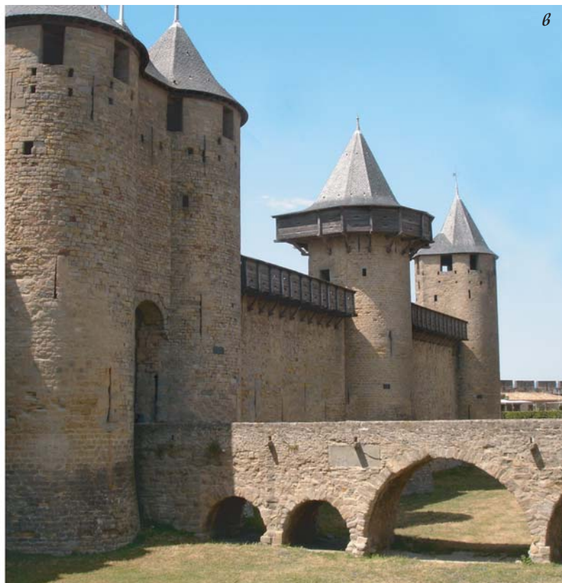
Іл. 149. Бойові галереї-горди: а – одноярусні, б – двоярусні (за Віолле ле Дюком), в – реставровані горди у замку Каркассон (Франція)
