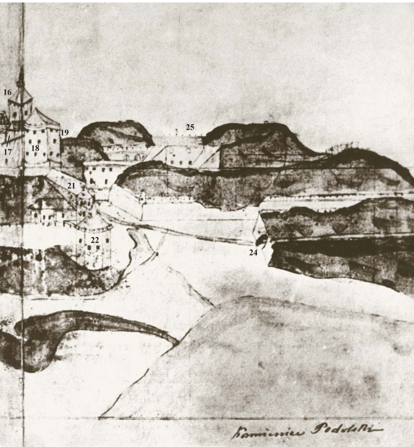
10 – башта Комендантська № 2, 11 – башта Тенчинська, 12 – башта Ляницькоронська, 13 – башта Ласька, 14 – башта Комендантська № 1, 15 – старостинські будівлі на замковому дворі, 16 – башта Денна, 17 – башта Ружицька, 18 – башта Рожанка, 19 – башта Нова Західна, 20 – північний оборонний мур, 21 – Пільна брама, 22 – башта Водна, 23 – кузня, 24 – Підзамкова брама, 25 – Новий замок. Опрацювала О.Пламеницька
