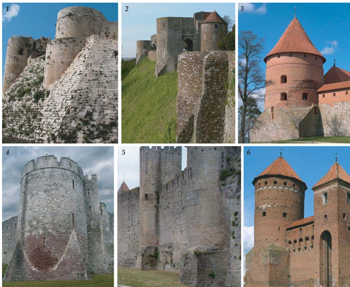
Іл. 178. Типологія архітектурного рішення основи башт у замках: 1 – Крак де Шевальє (Сирія), 2 – Чепстоу (Англія), 3 – Тракай (Литва), 4 – Дувр (Англія), 5 – Каркассон (Франція), 6 – Решель (Польща)
