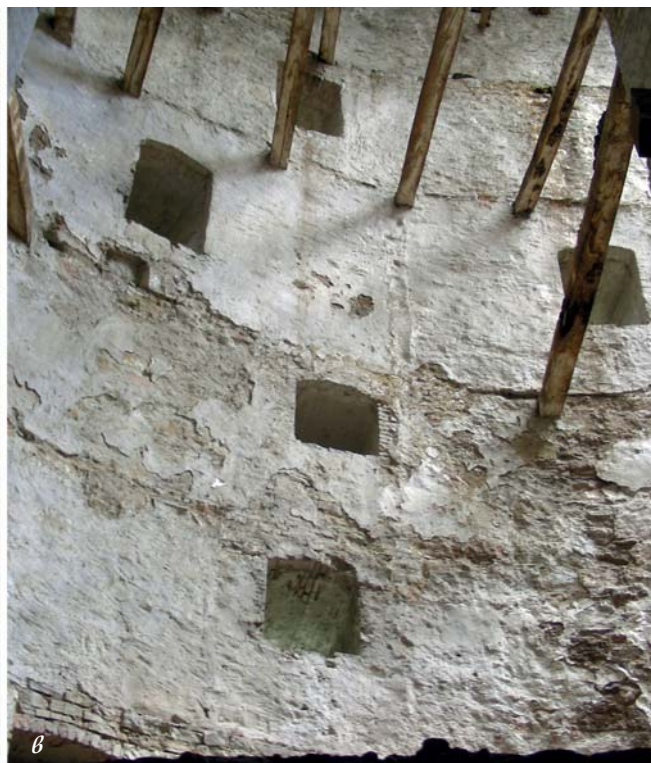
Іл. 386. Башта Стефана Баторія. Інтер'єр: а) бійниця 1585 р. на III ярусі давнього східного фасаду, що опинився в інтер'єрі східного крила 1785 р.; б) бійниця I ярусу північної стіни об'єму 1565 р.; в) фрагмент східної стіни об'єму 1585 р., в межах якої замуровано вихід у машикуль III ярусу.
