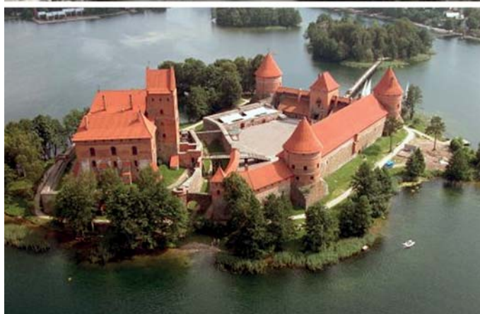
Л. 450. Замок Тракай (Литва). Цілісна реставрація (фото: web)
