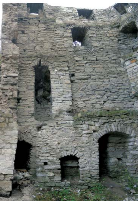
Ил. 231. Польська брама. Надбрамна башта: а – переріз північ-південь; б – переріз схід-захід (обмір Є.Пламеницької, А.Тюпича, Л.Лернера, П.Крисоченка, С.Буркацького); в – вигляд північної брами Надбрамної башти після обрушення північної стіни (фото О.Пламеницької); г – Надбрамна башта за креслеником 1800 р. (РДВІА)
