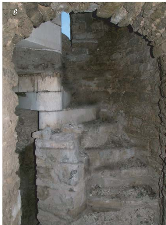
Ил. 146. Приміщення з внутрішньостінними сходами в башті Денній: а – бійниця у стіні, що була зовнішньою стіною вежі Денної; б – вигляд приміщення згори; в – відновлені кручені сходи. Фото О.Пламеницької
