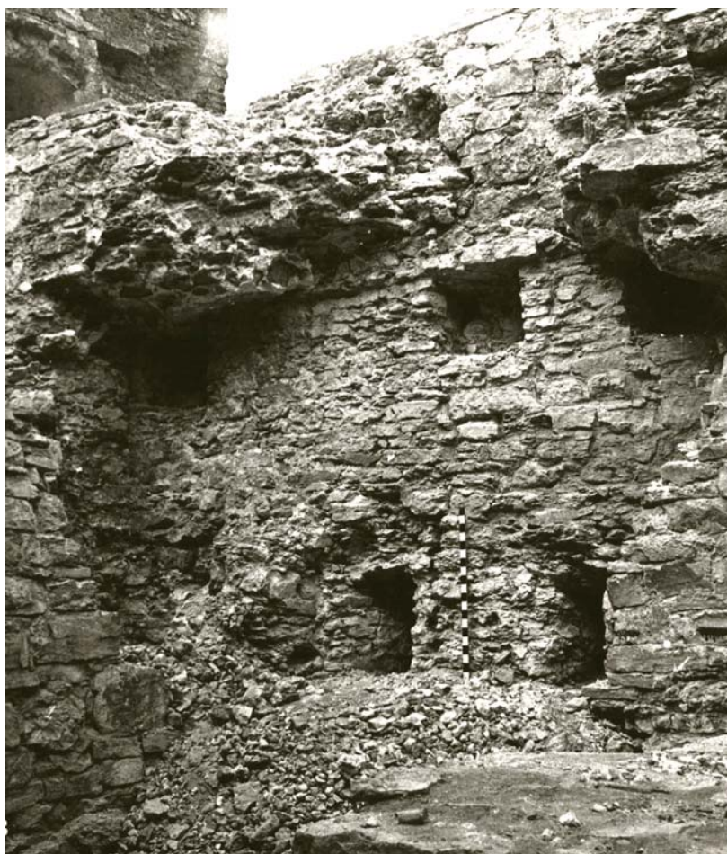
Лл. 67. Старий замок. Фрагмент стародавнього західного муру протозамку в межах башти Денної: а – план, переріз (дослідження і кресленик Є.Пламєницької), б – вид після зняття тиньку. Фото А.Тюпича
