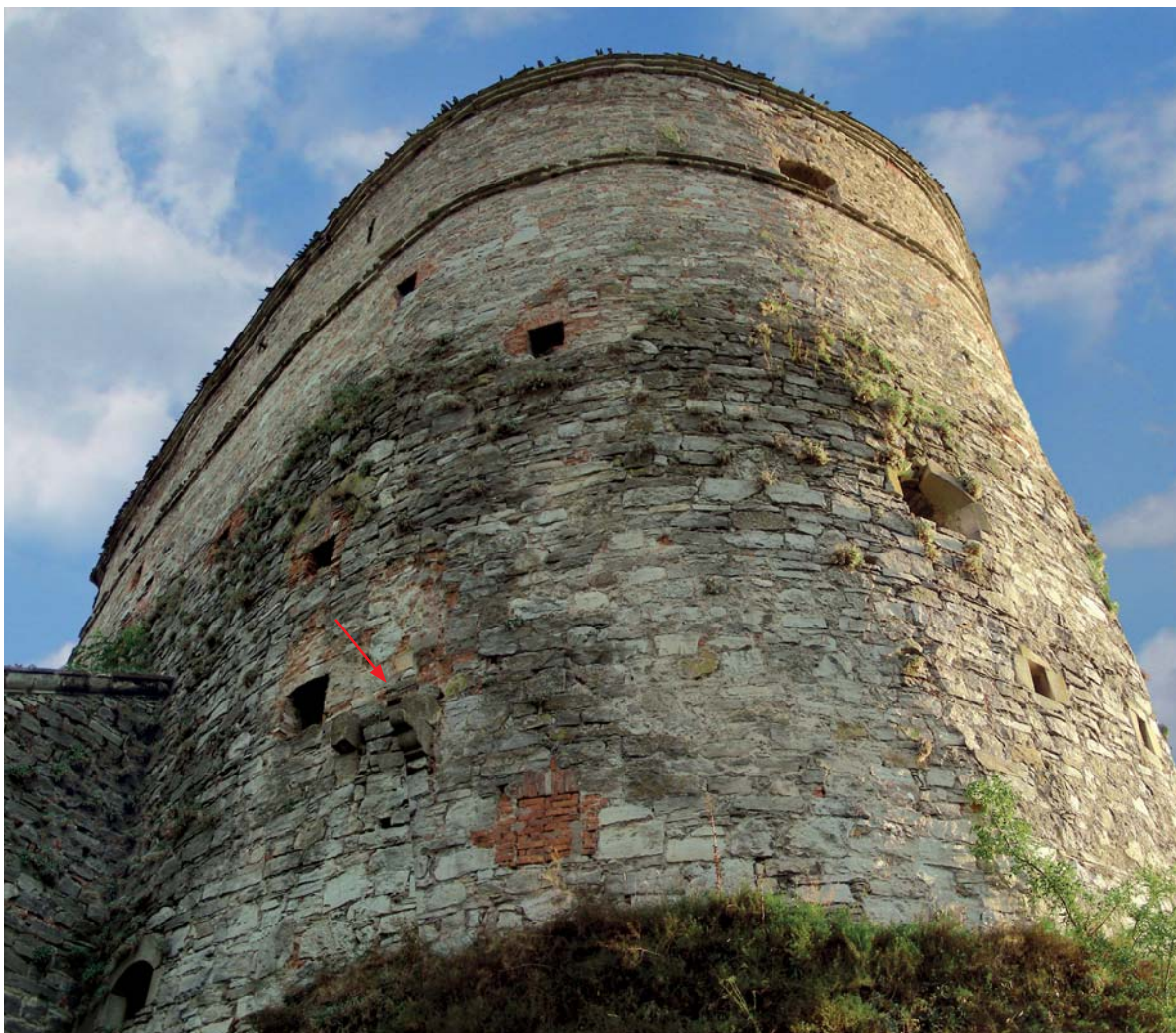
Лл. 304. Башта Стефана Баторія. Північний фасад. Залишки кронштейнів розібраного машикуля та замураваний цеглою його отвір у стіні (показані стрілкою). Фото О.Пламеницької
