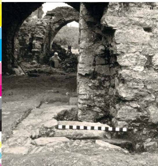
Іл. 232. Польська брама. Північна брама Надбрамної башти. Лицьова поверхня, що саморозкрилась на західному косяку брами: а – вигляд з півночі, б – вигляд зі сходу (фото Є.Пламеницької); в – паз для герси у південній брамі Надбрамної башти. Фото О.Пламеницької
