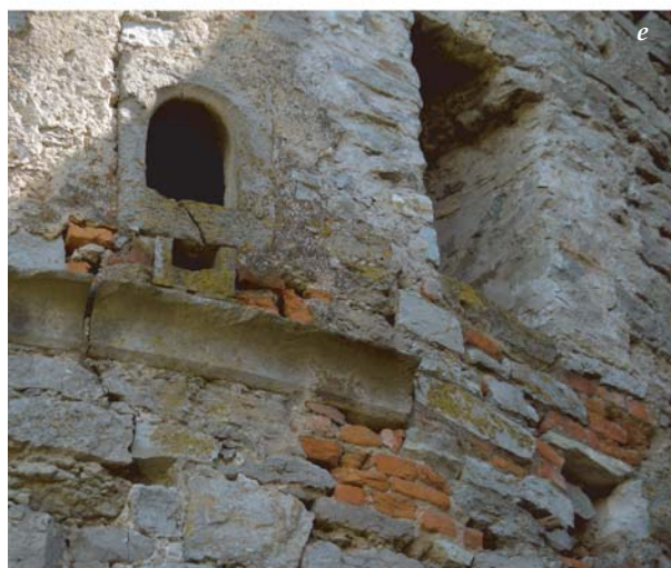
Ил. 186. Готична каменярка Старого замку литовського періоду: а – лоток водовідведення на башті Ляницькоронській; б – профілювання білокам'яних кронштейнів на баштах Рожанці, Ляницькоронській, Тенчинській, Водній; в – портал I ярусу башти Рожанки; г – портал II ярусу в башті Тенчинській; д – портал II ярусу в башті Ляницькоронській; е – вікно туалету на II ярусі башти Ляницькоронської; ж – сидіння і вікно туалету башти Ляницькоронської (інтер'єр). Фото і кресленики О.Пламеницької
