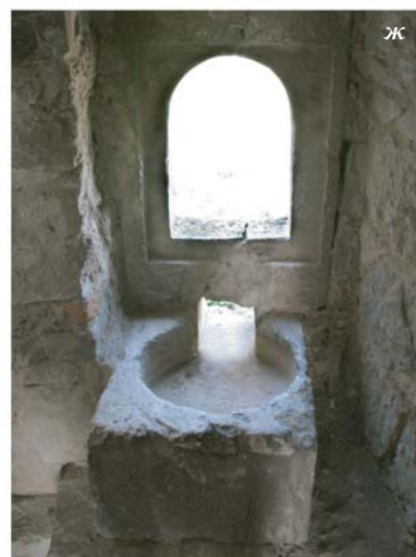
Ил. 186. Готична каменярка Старого замку литовського періоду: а – лоток водовідведення на башті Ляницькоронській; б – профілювання білокам'яних кронштейнів на баштах Рожанці, Ляницькоронській, Тенчинській, Водній; в – портал I ярусу башти Рожанки; г – портал II ярусу в башті Тенчинській; д – портал II ярусу в башті Ляницькоронській; е – вікно туалету на II ярусі башти Ляницькоронської; ж – сидіння і вікно туалету башти Ляницькоронської (інтер'єр). Фото і кресленики О.Пламеницької
