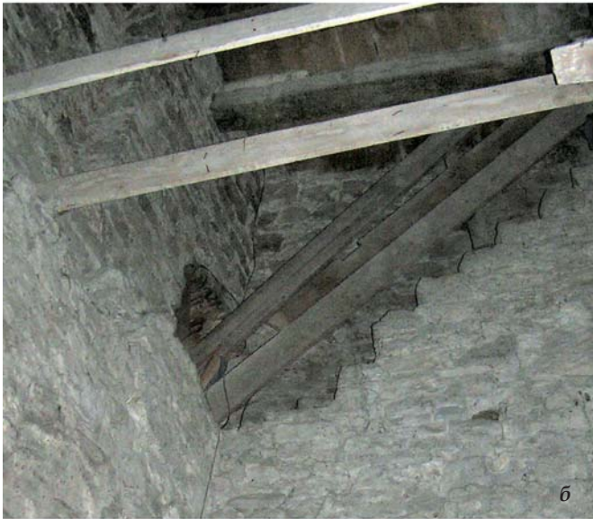
Ил. 240. Вежа-дзвіниця Петропавлівського кафедрального костьолу. Інтер'єр: а – внутрішньостінні сходи між II та III ярусами; б – продовження внутрішньостінних сходів на III ярус. Фото О.Пламеницької
