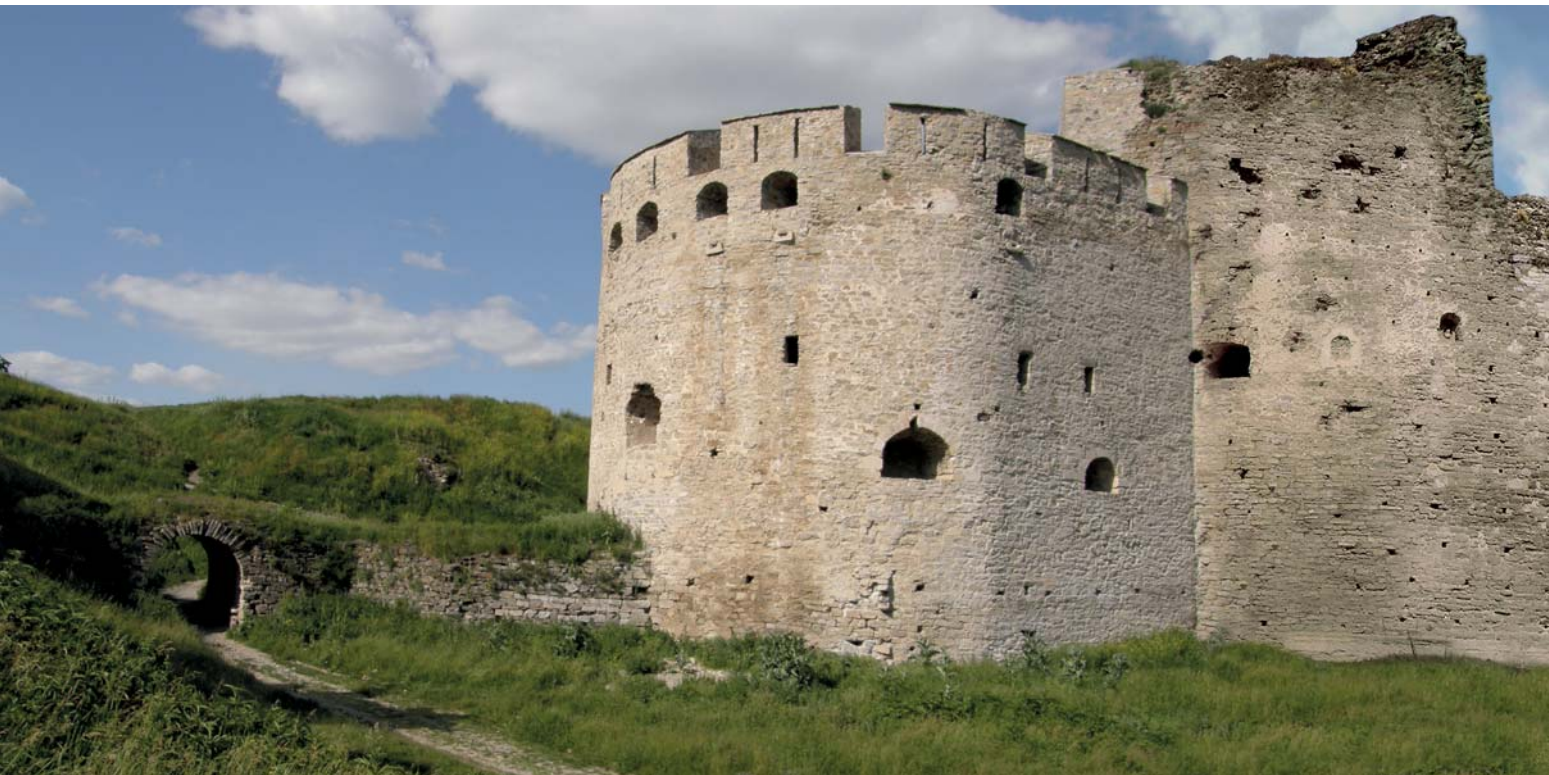
Іл. 322. Башта Нова Західна після реставрації II черги. Фото О.Карбовського, 2008 р.
