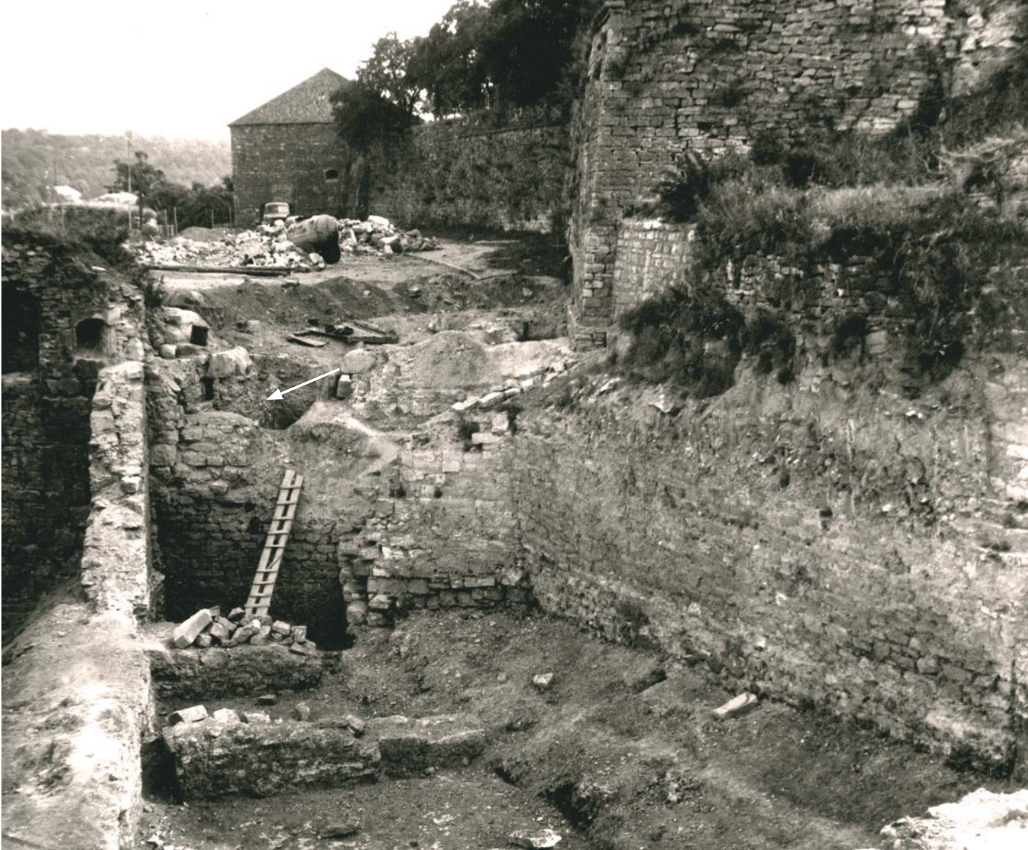
Іл. 76. Фрагмент західного муру Північної батареї з муруванням зубця стародавнього дако-римського муру між баштою Рожанкою та вежею Старою Рожанкою, розкритого під примуруванням (показане стрілкою). Фото О.Пламеницької
