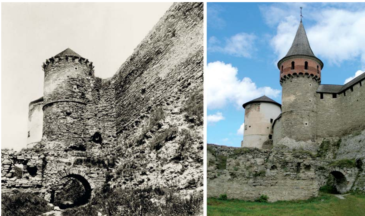
Іл. 430. Старий замок. Башти Тенчинська та південний мур замку до реставрації та після проведення консерваційно-реставраційних робіт. Автор проекту Є.Пламеницька. Фото Є.Пламеницької (1963 р.) та О.Пламеницької (2008 р.)
