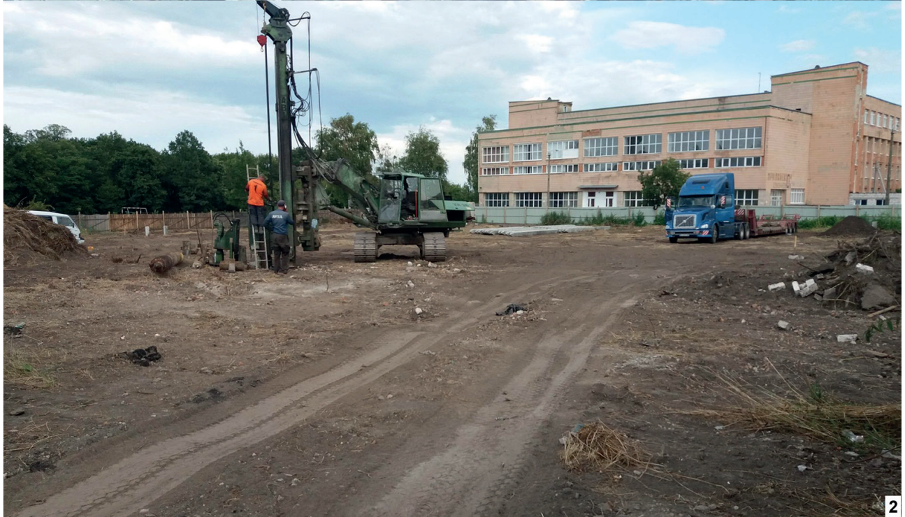
Рис. 7. Острог-Школа. 1 — супутниковий знімок Google з позначенням обстеженої території (дата зйомки — 9. 19. 2018 р.); 2 — будівельний майданчик у 2019 р. на місці археологічної пам'ятки.
