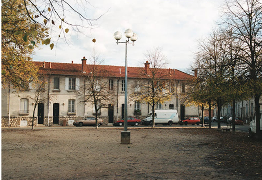
Рис.4.34. «Реконструкція» площі в Бордо. Lacaton & Vassal
