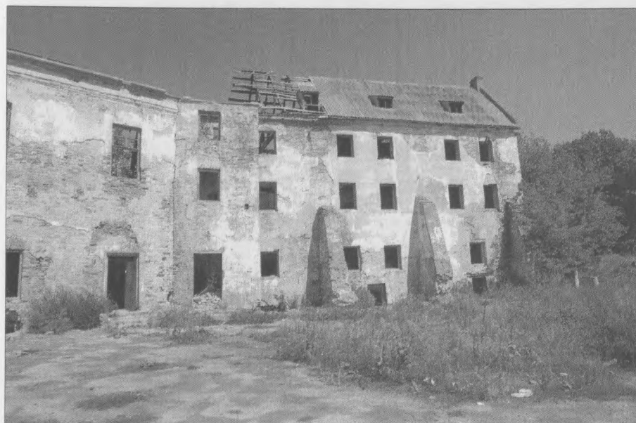
16. Klewań. Dziedziniec zamkowy, fragment elewacji zachodniego skrzydła, stan z 2016 r. Fot. Piotr Jamski
