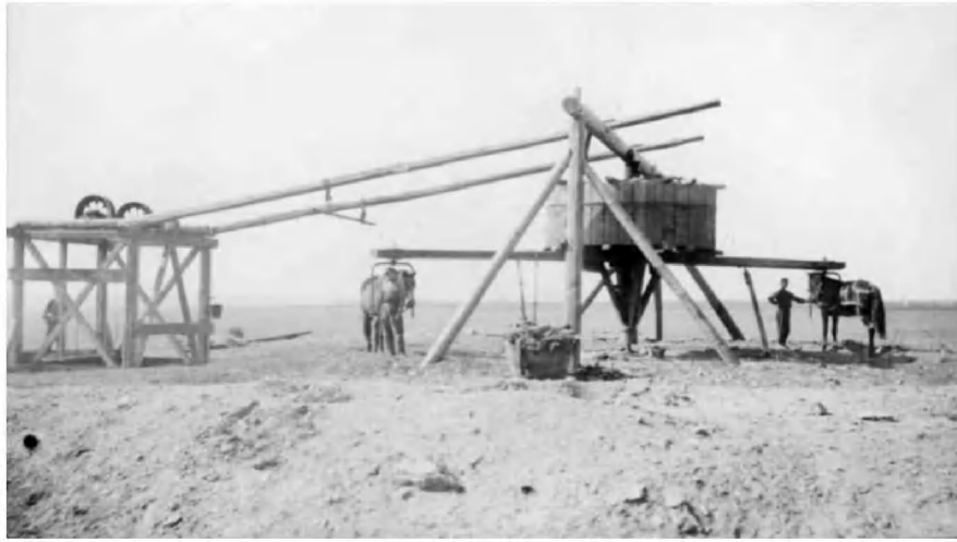
Будівництво першої домни. Строительство первой домны.
