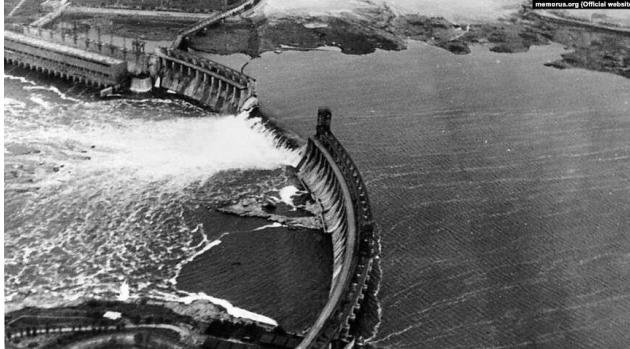
Рис. 2.4. Гребля ДніпроГЕС, підірвана Червоною Армією 18.08.1941 р., щоб призупинити наступ німецьких військ (м. Запоріжжя, Україна)
