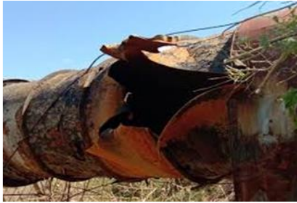
Рис. 2.10. Пошкодження артобстрілами ділянок трубопроводу каналу Сіверський Донець – Донбас призвело до припинення водопостачання населених пунктів Донбасу на кілька тижнів (2014-2021 рр.) [20]
