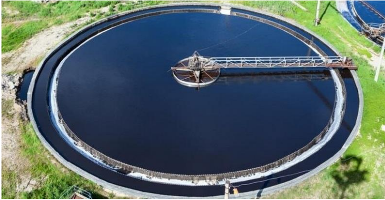
Рис. 8.3. Радіальний відстійник стічних вод
