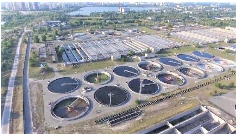
Рис. 11.10. Споруди для біологічного очищення стічних вод на Бортницькій станції аерації, м. Київ [17]
