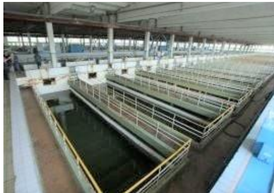
Рис. 11.6. Горизонтальні відстійники Дніпровської водопровідної станції, м. Київ [17]
