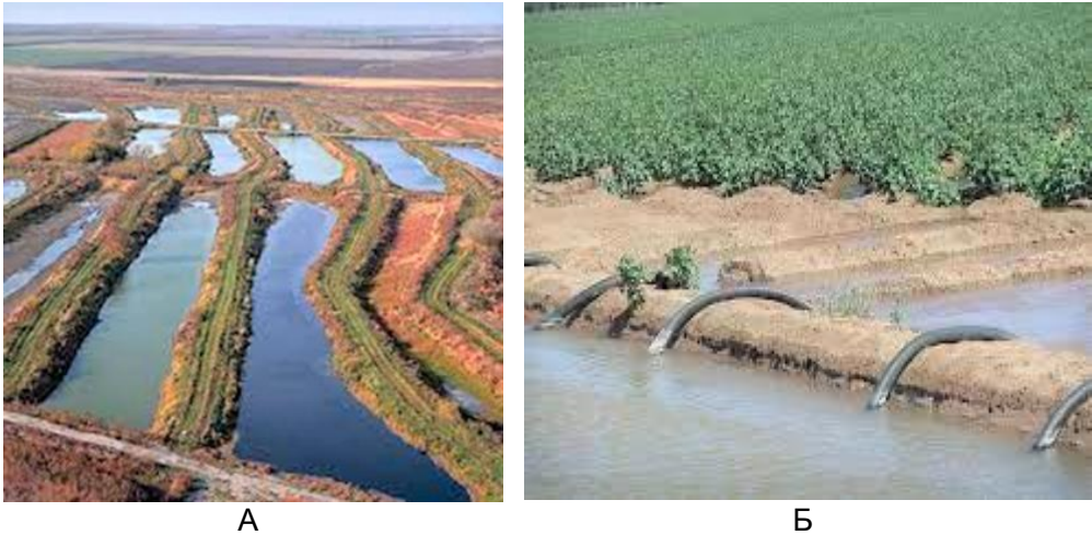
Рис. 9.8. Очищення стічних вод: поля фільтрації (А); поля зрошення (Б)
