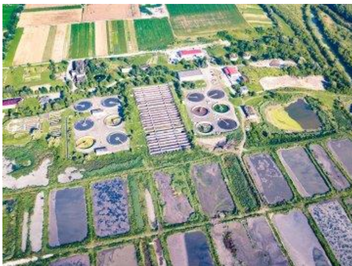
Рис. 11.13. Очисні споруди каналізації КП «Луцькводоканал» (с. Липляни Луцького району) з висоти пташиного польоту
