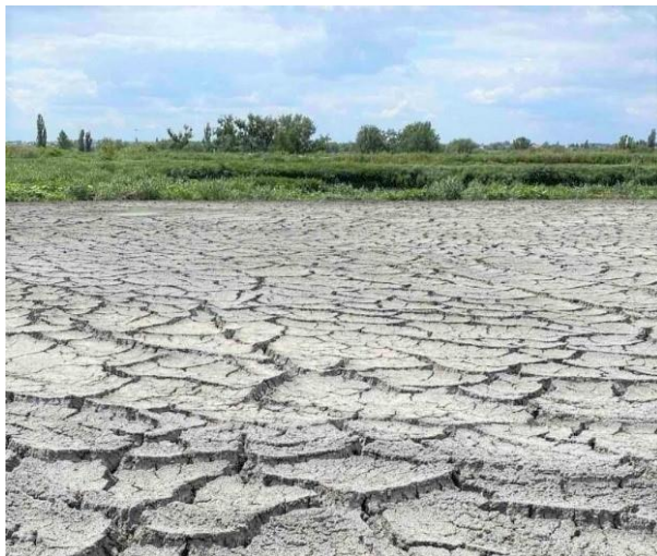
Рис. 11.15. Мулові карти з осадом стічних вод на очисних спорудах каналізації КП «Луцькводоканал»
