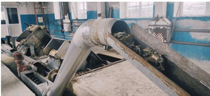
Рис. 8.1. Затримані на ґратах предмети із стічних вод
