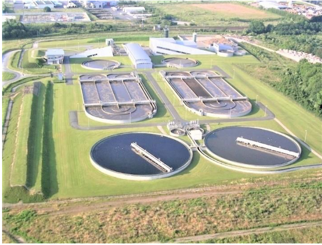
Рис. 4.20. Загальний вигляд споруд для очищення стічних вод
