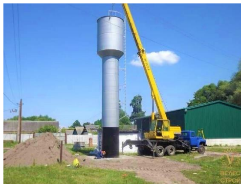
Рис. 4.15. Монтаж водонапірної вежі у сільській місцевості
