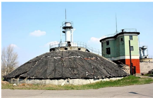
Рис. 9.7. Зовнішній вигляд метантенка на Бортницькій станції аерації (Київ)
