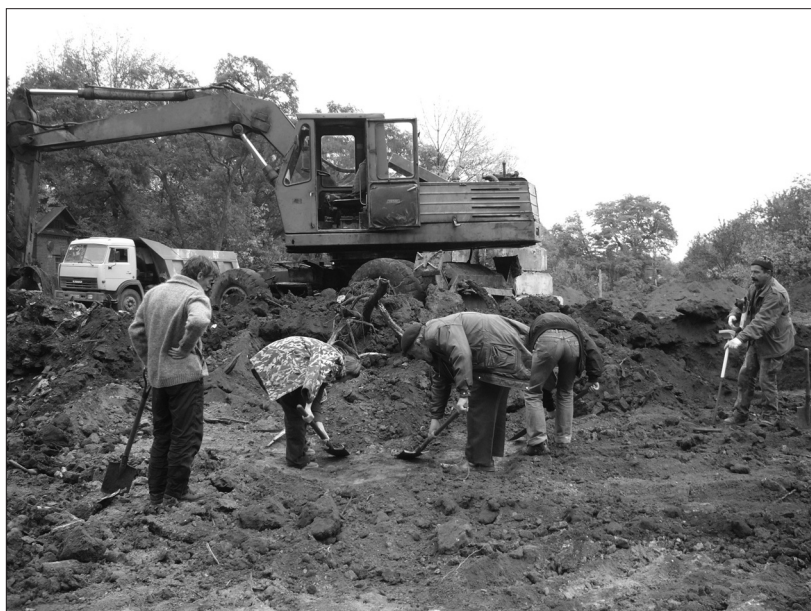
Рис. 23. Наглядові роботи на початку спорудження котловану. Робочий момент.
