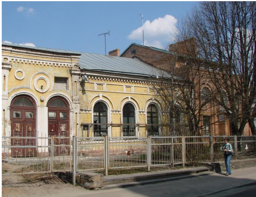
Синагога, м. Житомир. Зведена 1911 р. Зруйнована 2013 р. Фото 2010 р.
