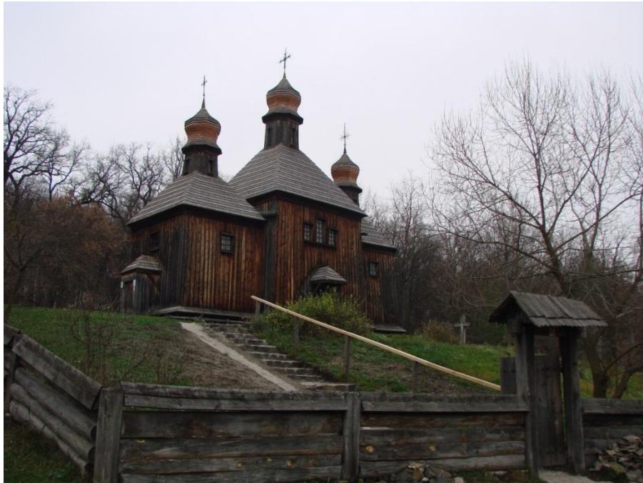
Церква Св. Архистратига Михаїла (1600 р.) з с. Дорогинка Фастівського району. 1971 р. храм перенесено до музею
