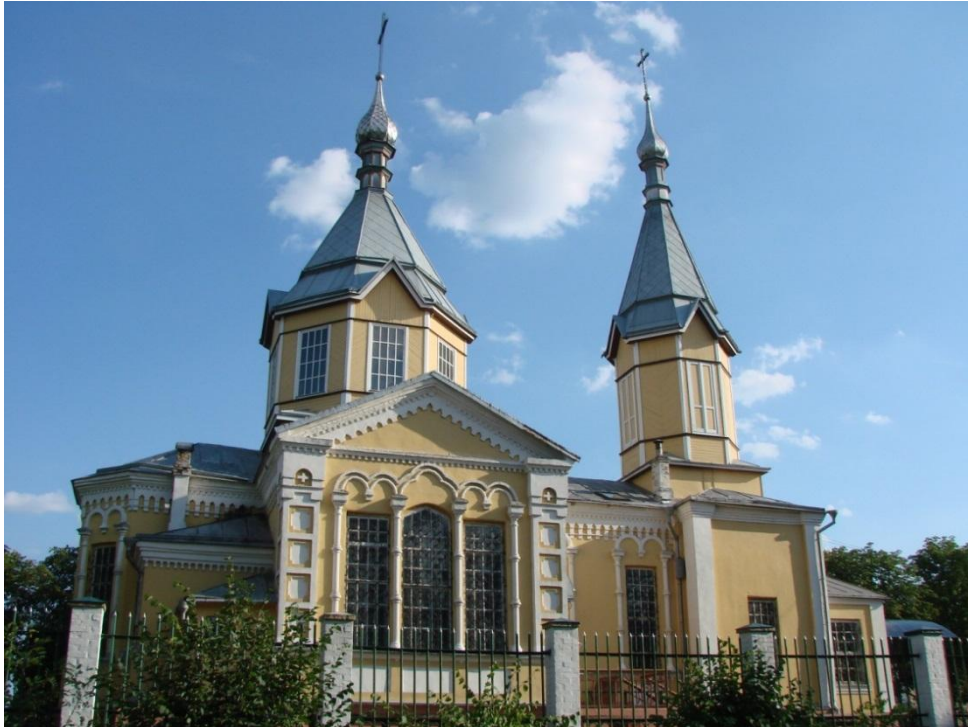
Свято-Троїцька церква (1906-1909 рр.) у м. Ірпінь. Дерев'яна, обкладена цеглою (окрім бані та дзвіниці)
