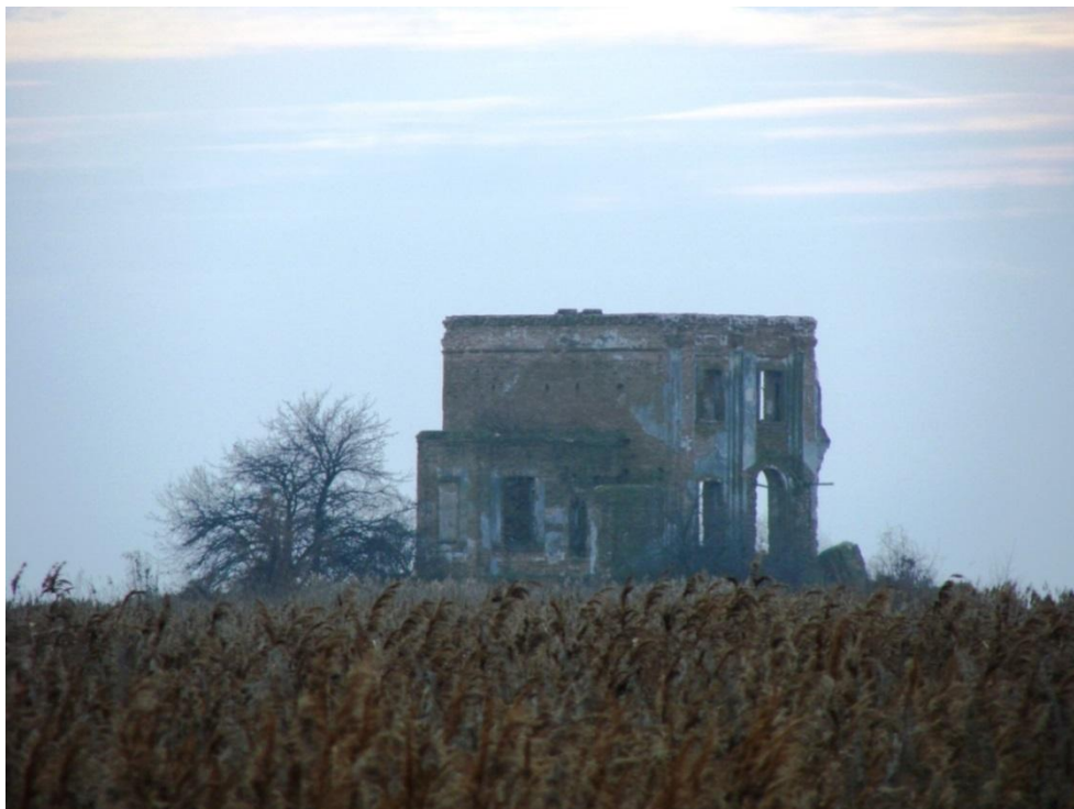
Руїни церкви Св. Іллі (бл. 1912 р.) у с. Циблі. Після створення Канівського водосховища церква опинилася на острові, тому дістатись безпосередньо до храму складно
