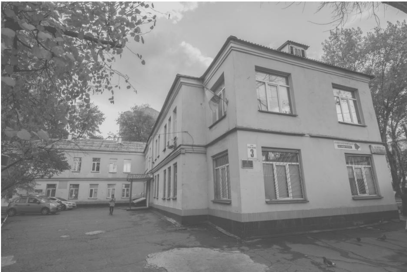
Будівля колишнього дитячого садка Микільської Слобідки (тепер медична установа), 2-а половина 1930-х років. Вулиця Раїси Окіпної, 3. Фото 2016 р.
