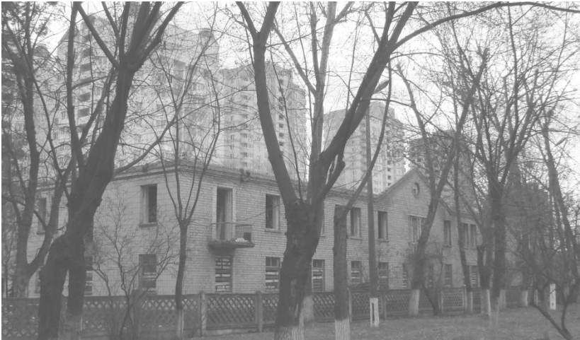
Вул. Попудренка, 36-А. Зруйновано в 2009 р.
