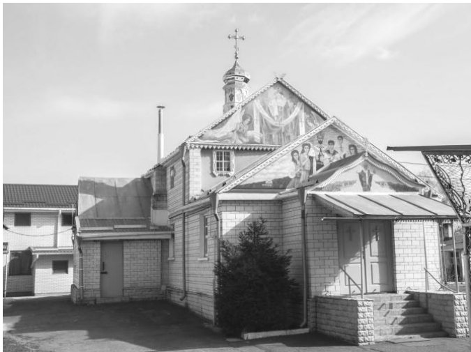
Обкладена цеглою Свято-Покровська церква, фото 2017 р.
