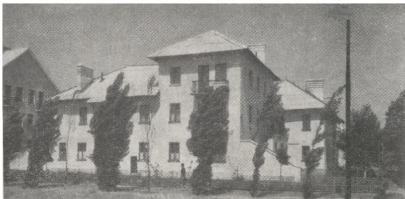
Забудова селища Аварійне, фото 1970-х рр..
