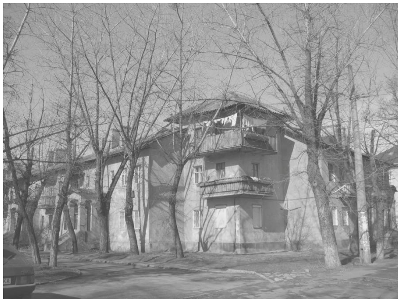
Вул. Гната Хоткевича, 12. Зруйновано в 2009 р.
