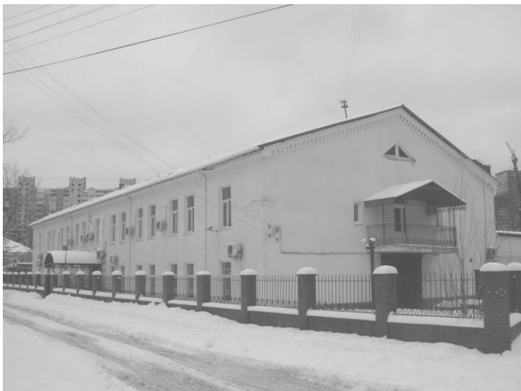
Будівля громадського призначення на вулиці Лобачевського, 23-В. Фото 2017 р.
