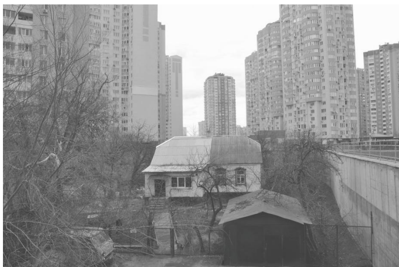
Рештки вул. Позняківської, поховані в бетонному мішку. Фото 2017 р.
