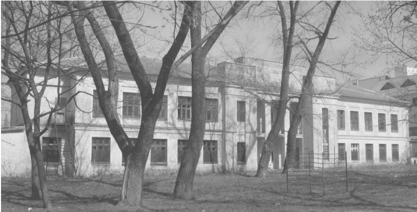
Будівля колишнього дитячого садка селища Дарницького м'ясокомбінату, 2-а половина 1930-х років. Вулиця Зрошувальна, 3. Фото 2015 р.
