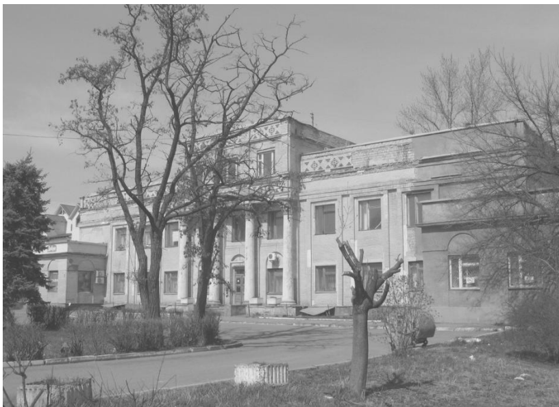
Заводоуправління (1930-ті), на першому поверсі якого знаходився клуб. Фото 2015 р.
