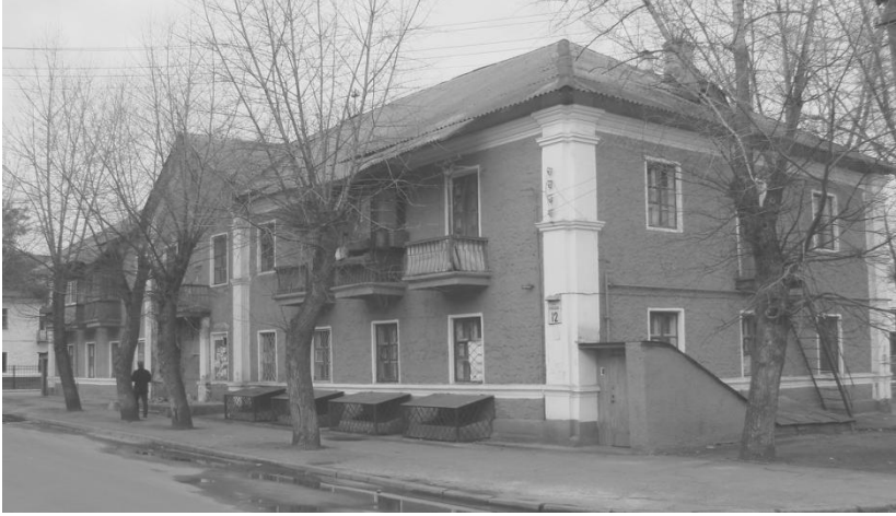
Вул. Лебедева, 12. Зруйновано в 2010 р.
