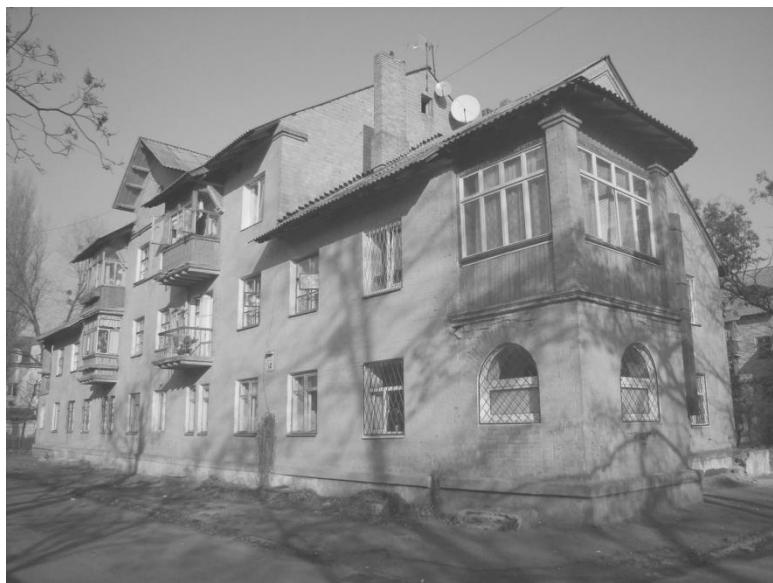
Вул. Мініна, 14-А. Фото 2009 р.
