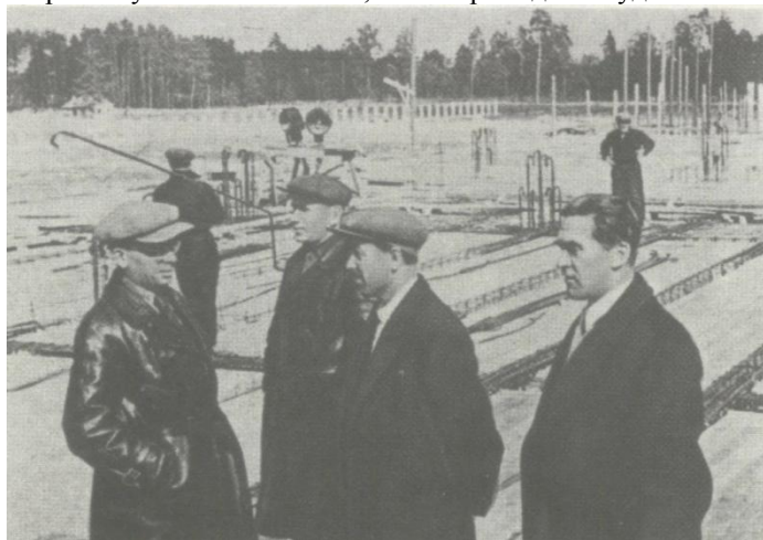
Початок будівництва на Соцмісті, фото середини 1930-х рр.
