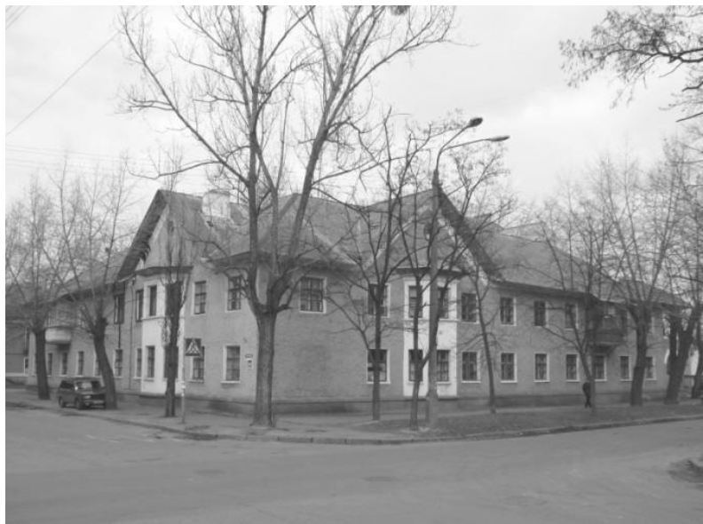
Будинок серії І-228 у наріжному виконанні (1951 р.) на вулиці Краківській, 19/10, фото 2015 р.
