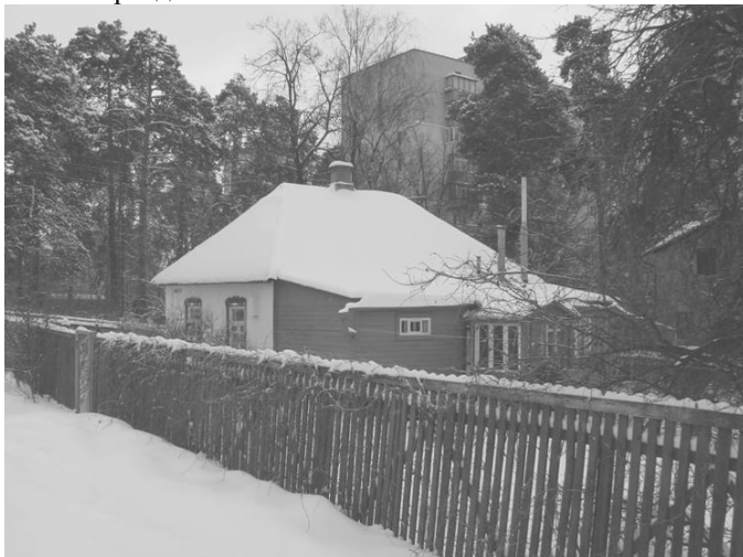
Зразок повоєнної приватної забудови ДВРЗ – будинок на вулиці Марганецькій, 83/1, фото 2017 р.
