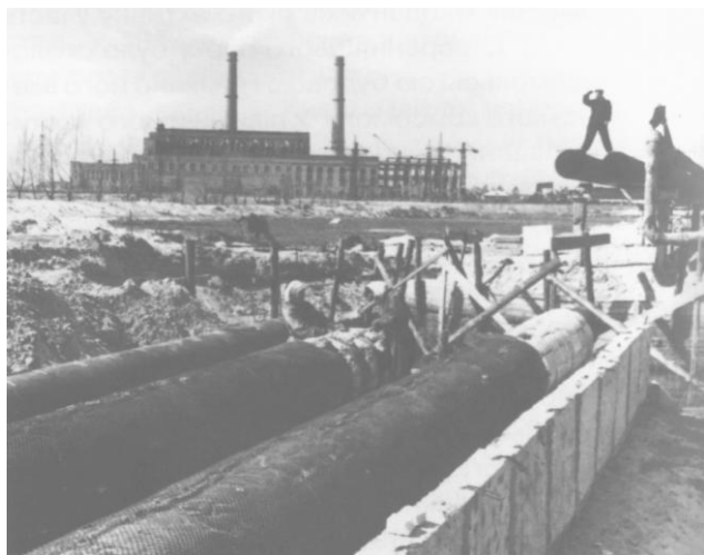
Будівництво тепломережі і ДТЕЦ, 1958 р.
