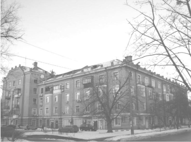
Будинок на бульварі Верховної Ради, 13. Призначався для ІТР гумовогенераторного заводу. 4-поверховий житловий будинок з 5-поверховою бічною прибудовою, з елементами конструктивізму. Побудований у 1940 році. Під час війни зазнав часткових руйнувань, по війні був відновлений, фасад значної переробки не зазнав, фото 2017 р.
