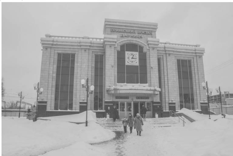
Сучасний вестибюль вокзалу з боку Старої Дарниці, фото 2017 р.
