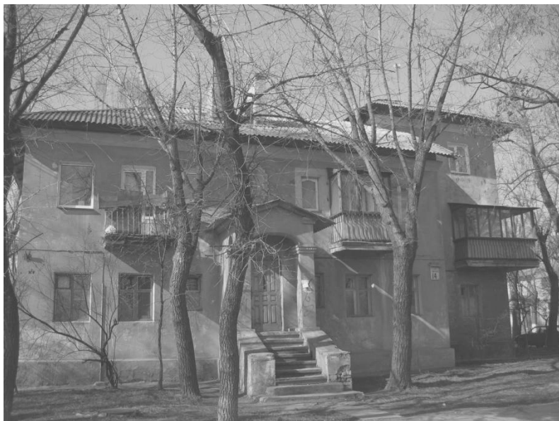
Вул. Гната Хоткевича, 14. Зруйновано в 2009 р.
