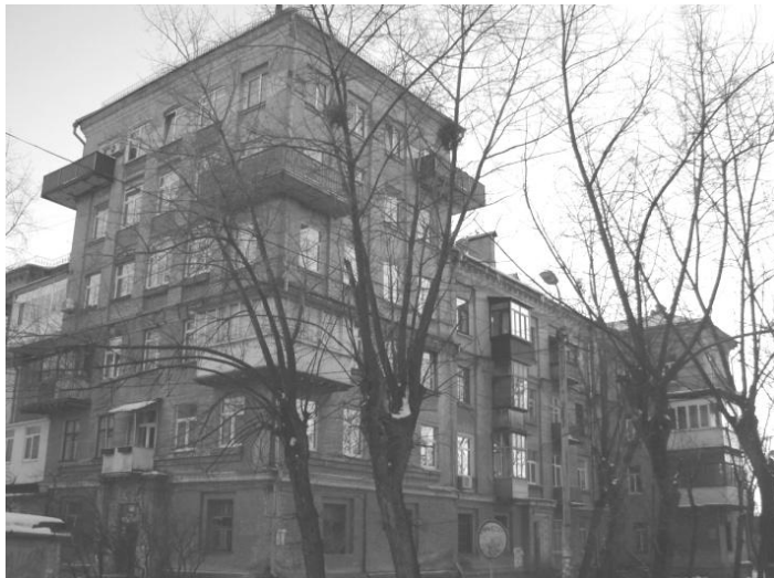
Будинок на вулиці Краківській, 5. 4-поверховий житловий будинок СК-3 з 6-поверховою наріжною «вежею». Побудований вочевидь у 1936-40 роках. Під час війни зазнав часткових руйнувань, по війні був відновлений, фасад зазнав незначної переробки. Фото 2017 р.
