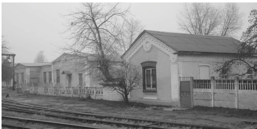
Колійна казарма на вулиці Зрошувальній, 1, фото 2015 р.
