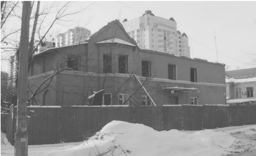
Вул. Лебедева, 15. Зруйновано в 2010 р.
