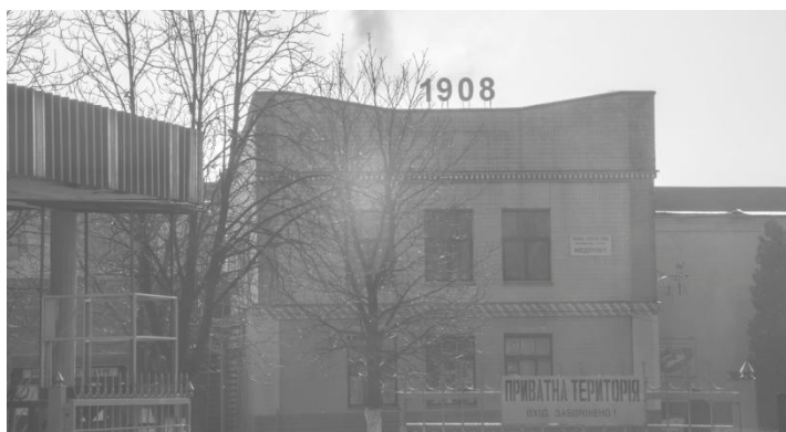
Корпус заводу, із символічною датою побудови. Фото 2017 р.
