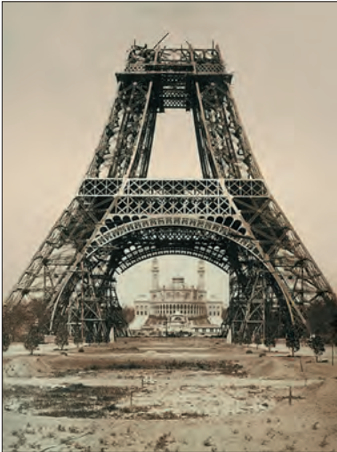
Будівництво Ейфелевої вежі у Парижі. Фото XIX ст.
