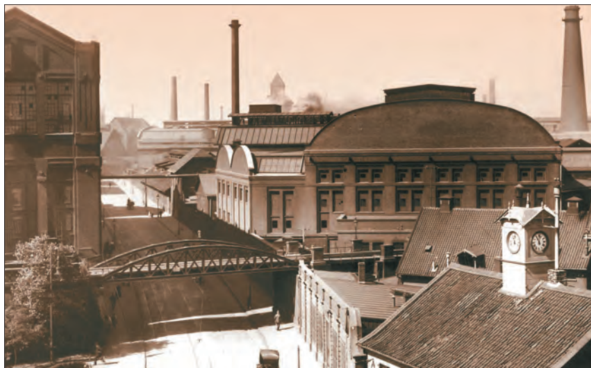
Завод Круппа в Ессені. Фото ХХ ст.
