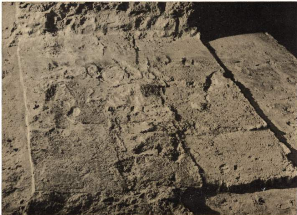
Рис. 88. Остатки стены и битая плинфа первоначальной кладки западного фасада.
