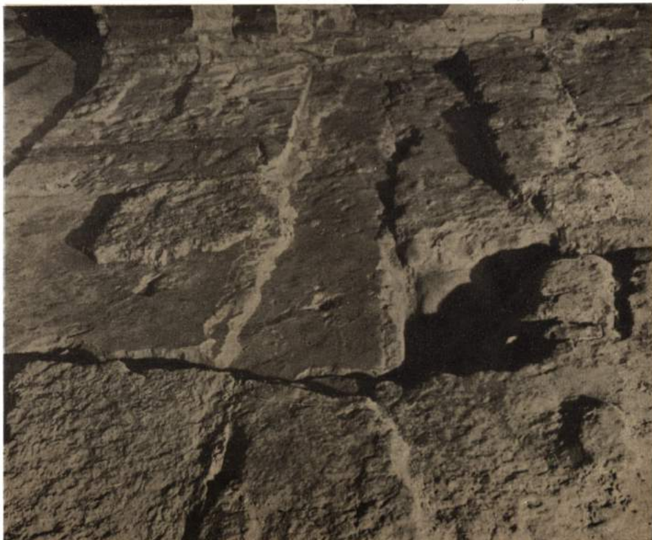
Рис. 87. Место стыковки фундаментов нартекса и основной части сооружения.
