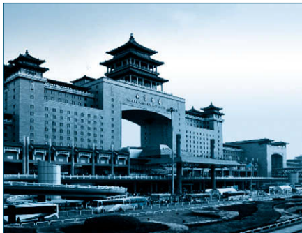
Рис. 1. Західний залізничний вокзал
