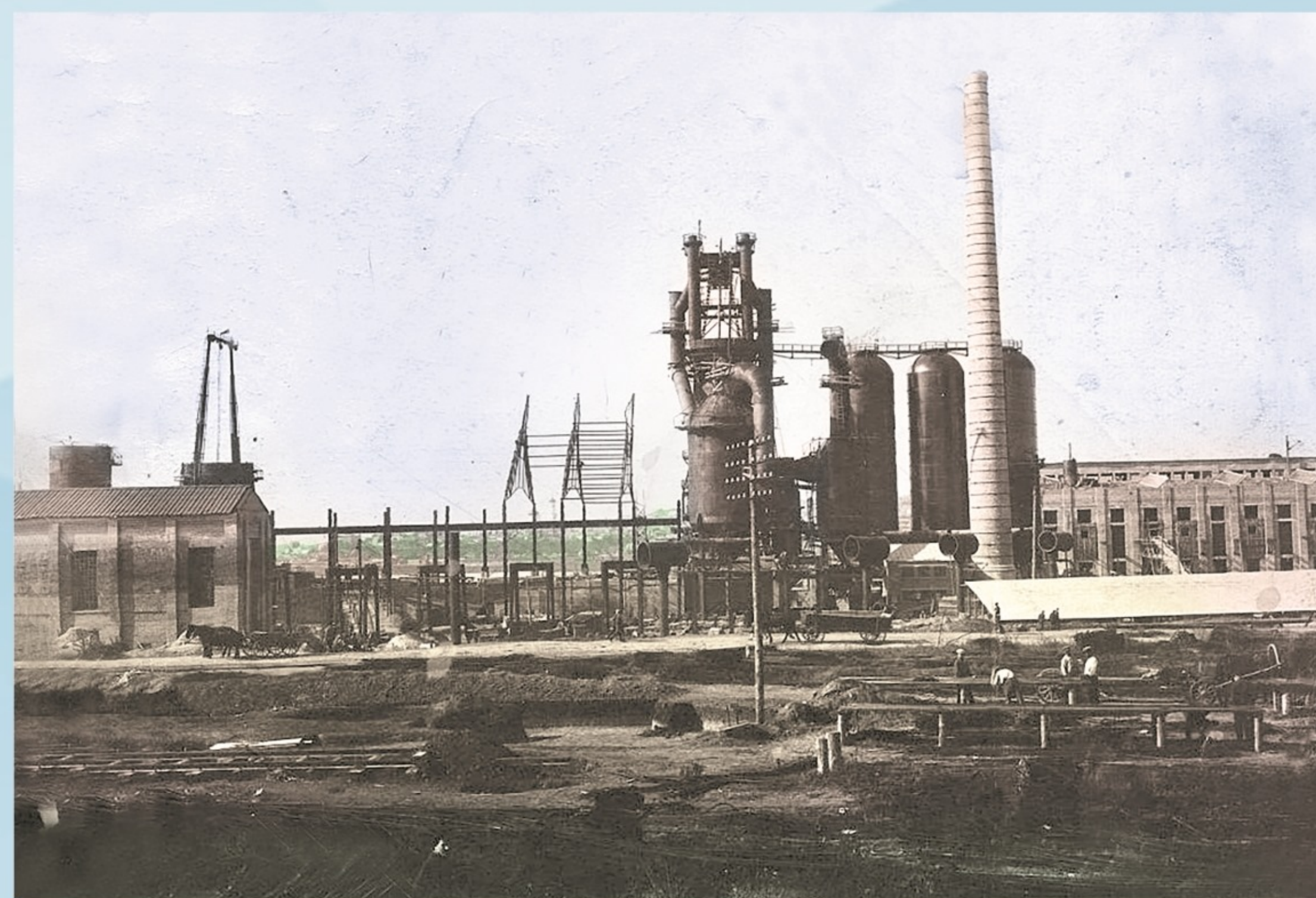
Будівництво доменного цеху «Азовстали». 1932 рік
