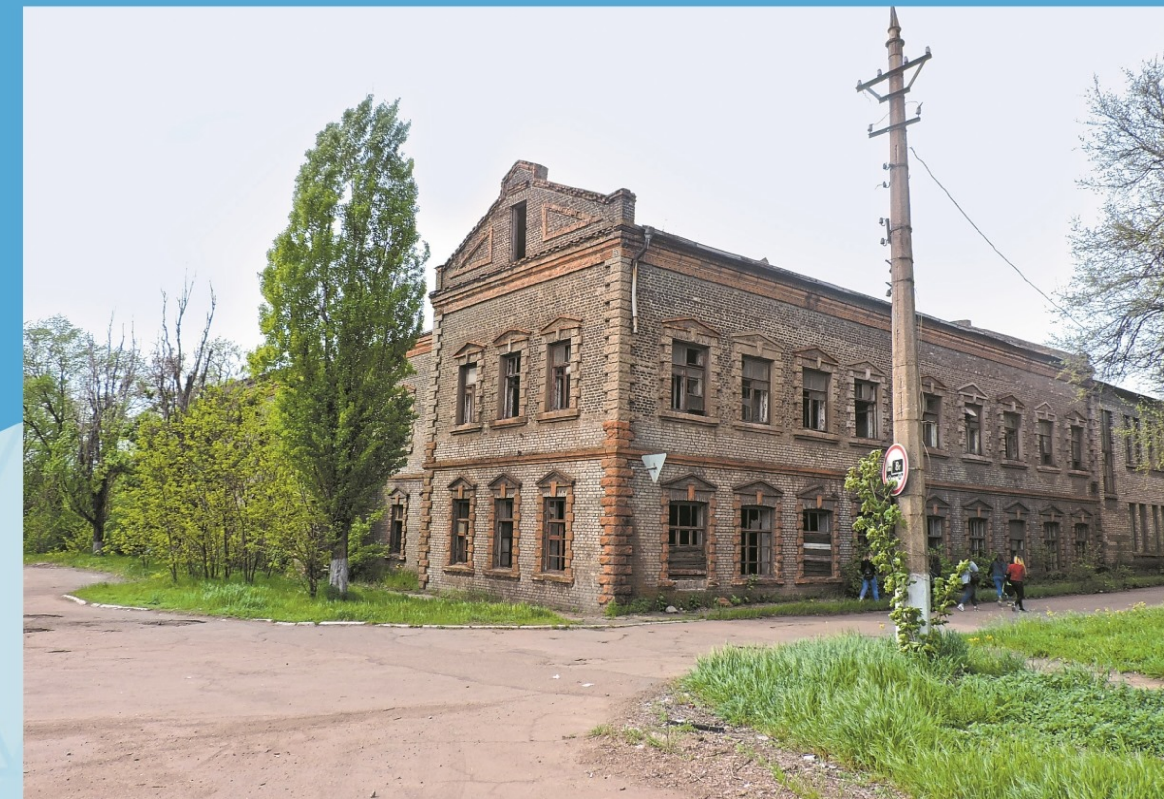
Комплекс будівель поч. 20 ст. заводу управління «Російський провіданс». Фото: Іван Стичинський. 2019 р.
