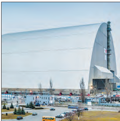
Арка безпеки над 4-м енергоблоком. 2016 р.
