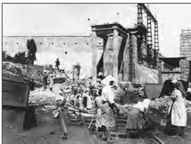
Жінки на відбудові Дніпрогесу. Запоріжжя. 1947 р.
