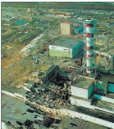
Зруйнований 4-й енергоблок Чорнобильської АЕС. 1986 р.
