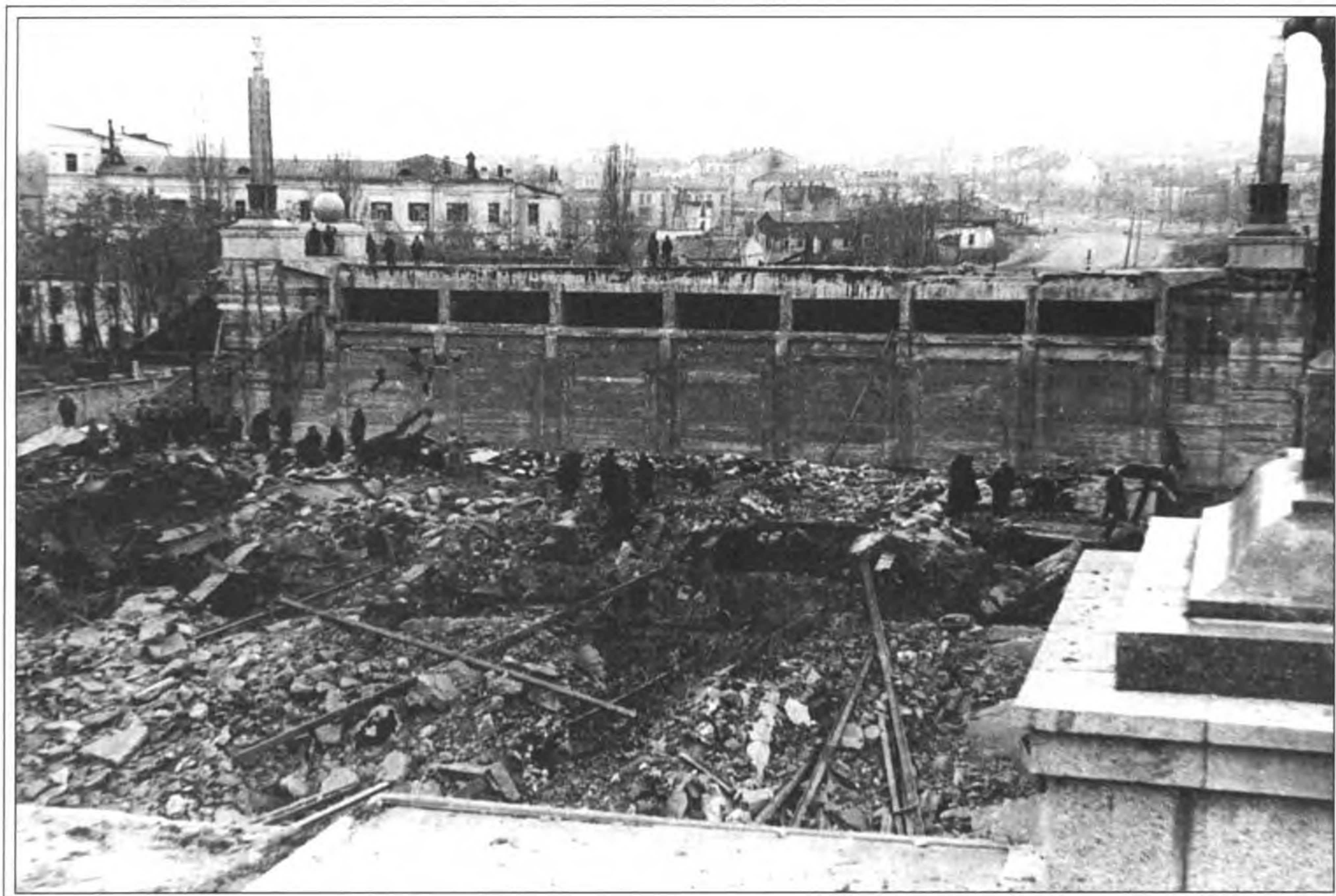
Деміївський шляхопровід над залізничними коліями, зруйнований німцями при відступі з Києва.
