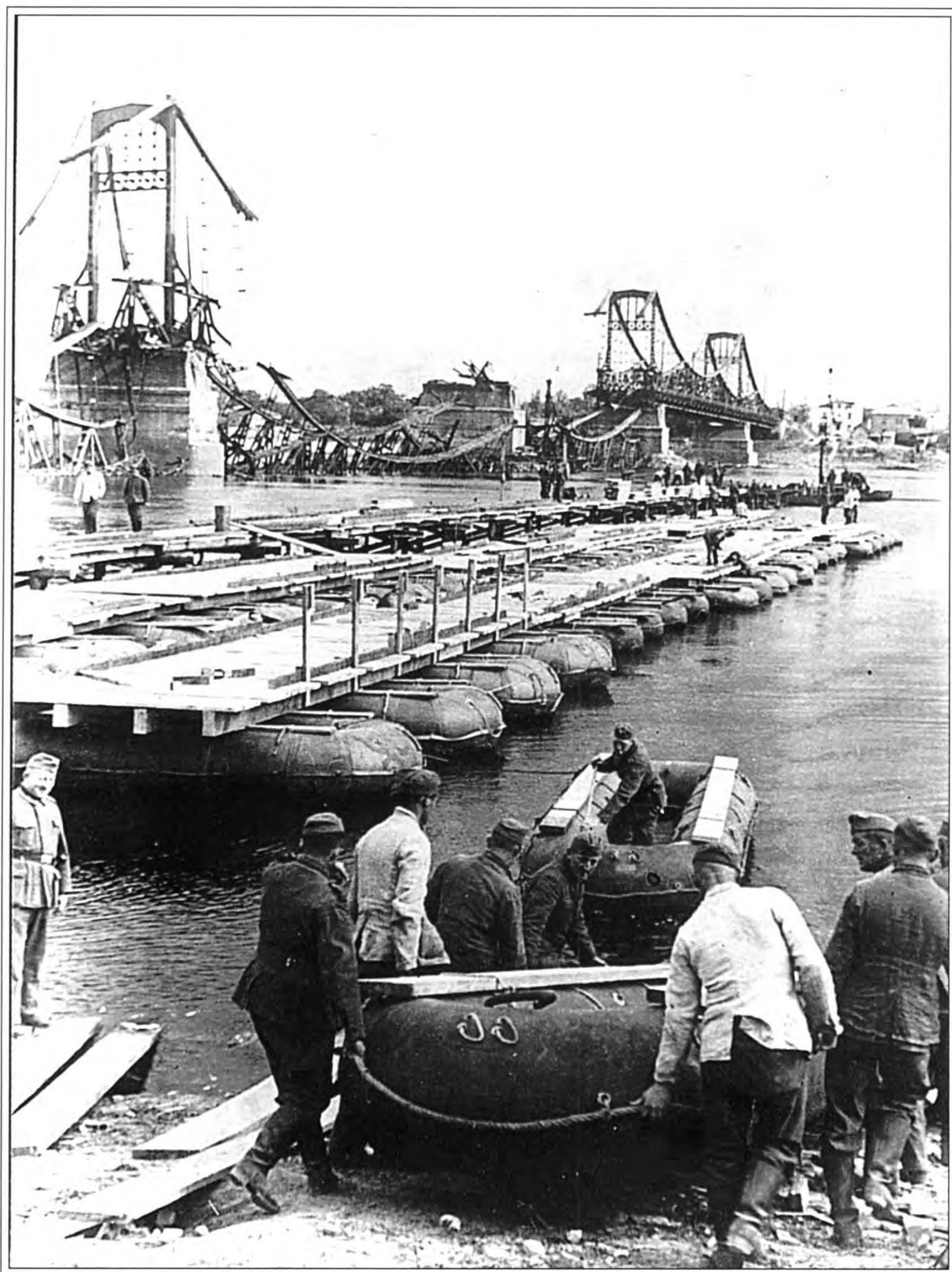
Німецькі сапери наводять понтонну переправу на надувних гумових човнах через Дніпро нижче зруйнованого моста ім. Є. Бош.
