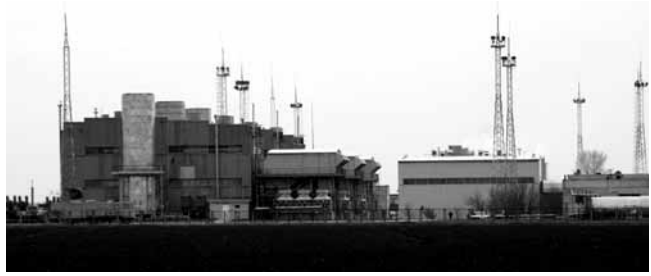
Газокомпресорна станція “Софіївська”
