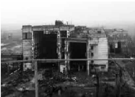
Демонтаж Пальмірського цукрозаводу
