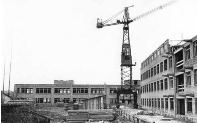
Будівництво нових корпусів райлікарні
