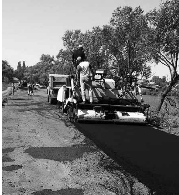
Ремонт дороги біля с. Гладківщина
