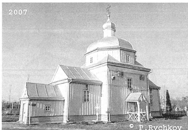
Рис. 5. Обшивка блок-хаузом церкви Успіння Богородиці, с. Караєвичі Рівненського району. Фото П. Ричкова
