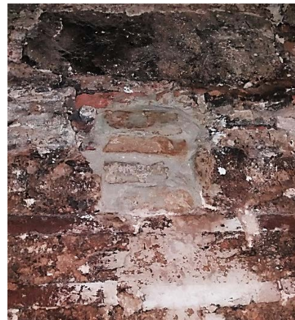
Рис. 17. Одне з закладених прямокутних гнізд у північному приміщенні
