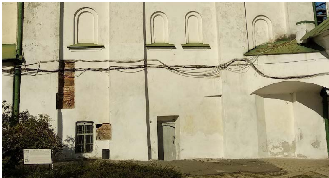
Рис. 8. Фрагмент південного фасаду Троїцької надбрамної церкви. Фото 2018 р.
