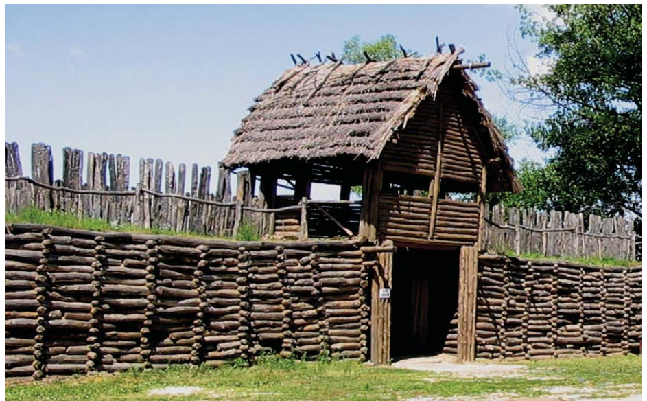
Ил.13. Пример двухъярусного укрепления. Польша. Город Бискупин. Реконструкция простой деревоземляной стены из городен, которые забучены землей. Боевая площадка защищена частоколом. Вид со стороны поселения.
