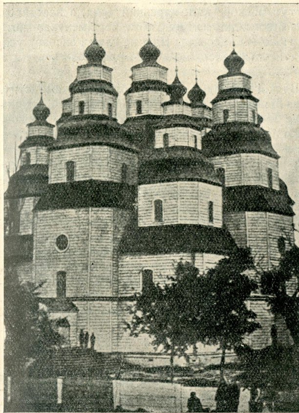
Вигляд після перебудови 1888 р.
