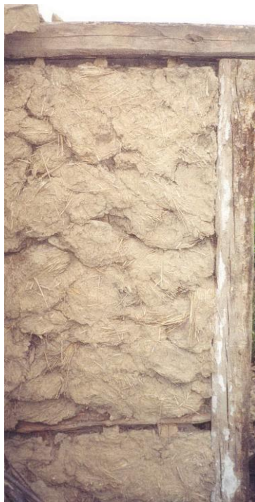
Фото 86. Конструкція риглевої стіни. Село Кругі. Кодимський район. Фото автора
