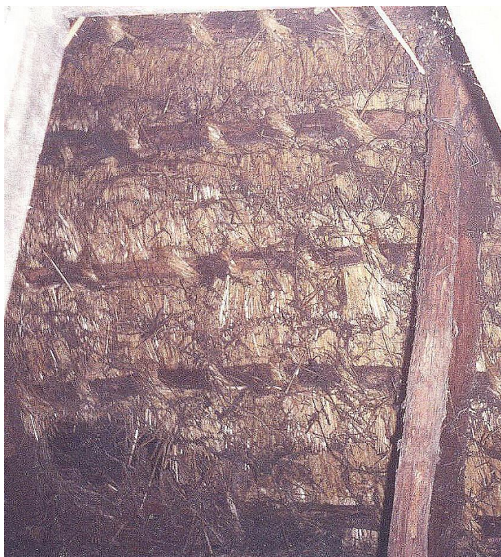
Фото 90. Техніка вкриття даху околотом. Село Перейма. Балтський район. Фото автора
