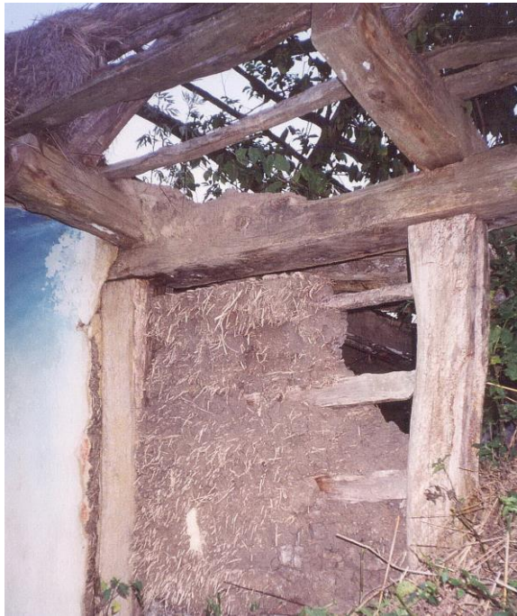
Фото 87. Конструкція риглевої стіни. Село Івашків. Кодимський район. Фото автора
