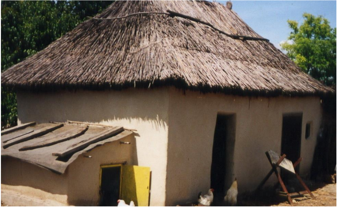
Фото 162. Вкриття будівлі способом «по – руськи». Повіт Тульча. Фото автора
