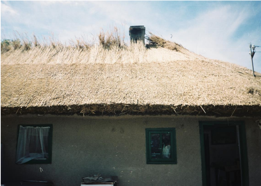
Фото 163. Вкриття будівлі способом «по – німецьки». Повіт Тульча. Фото автора
