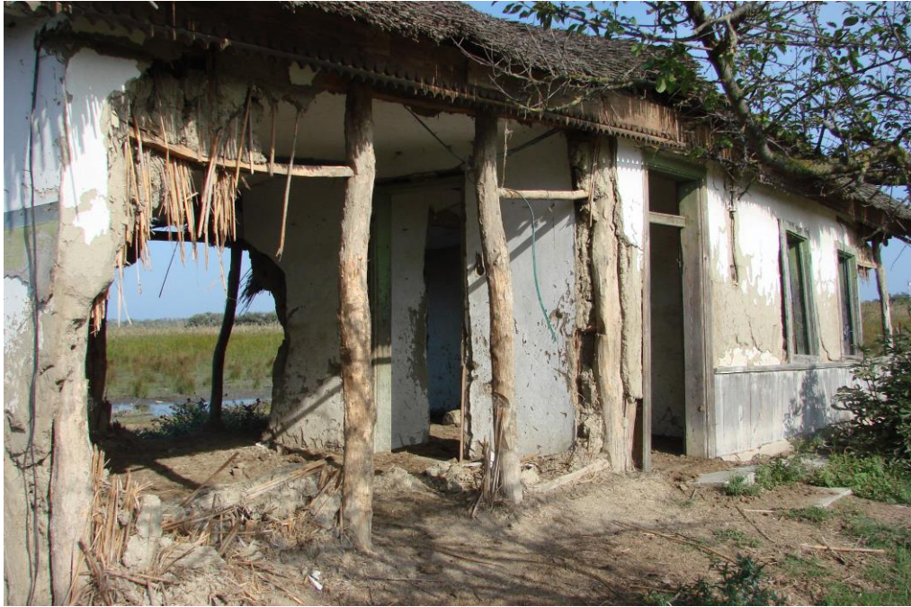
Фото 159. Фрагменти каркасу стін трьохкамерного житла. Село Сфінту Георге. Повіт Тульча. Фото автора
