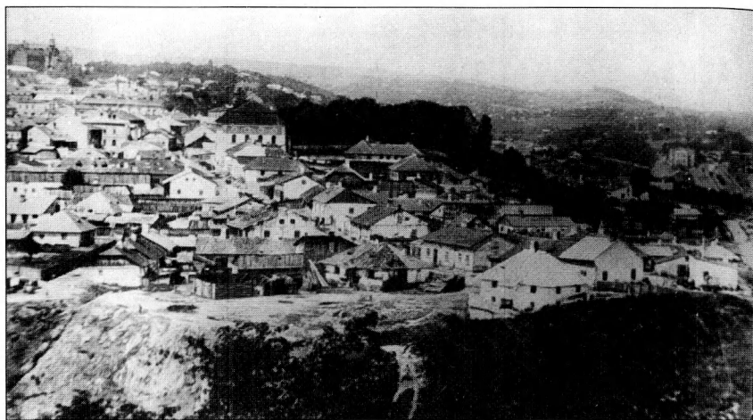
„Єврейський квартал”. Вигляд з північно-східного передмістя. В центрі – вул. Сінагогенгассе (нині вул. А.Барбюса) та будівля Великої синагоги.
