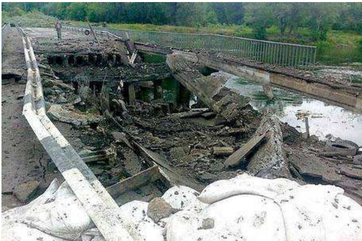
Фото. 3.8. Зруйнований у 2014 р. автомобільний міст через річку Сіверський Донець 1
