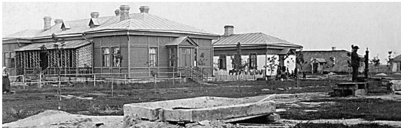
Фото 2. Маєток «Затишшя». Будинок завідувача маєтком. 1902 рік
