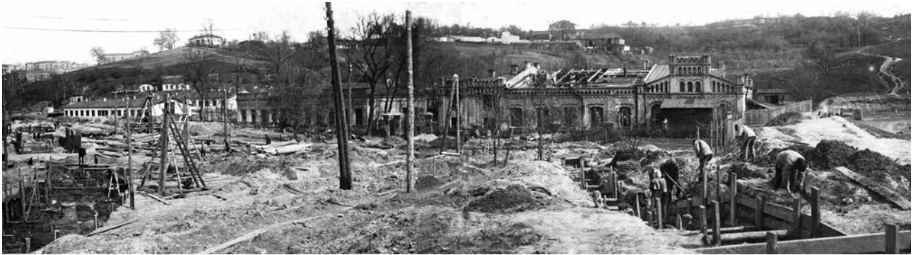
Прокладання каналізаційного колектора в районі Троїцької площі (нині – НСК «Олімпійський»)
