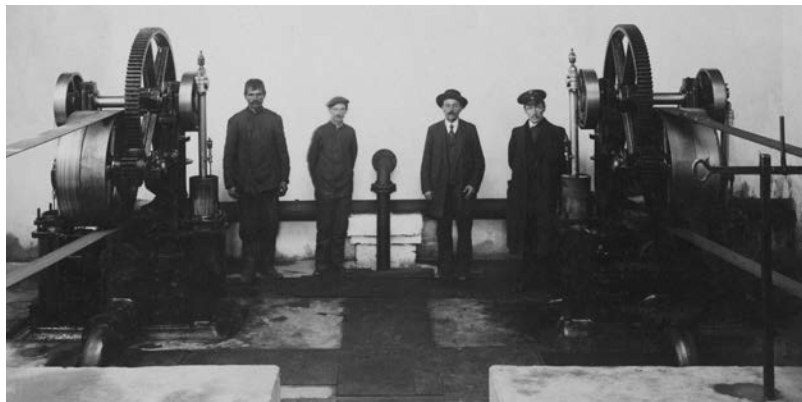
Машинний зал Подільської помпової станції (1894 р.)
