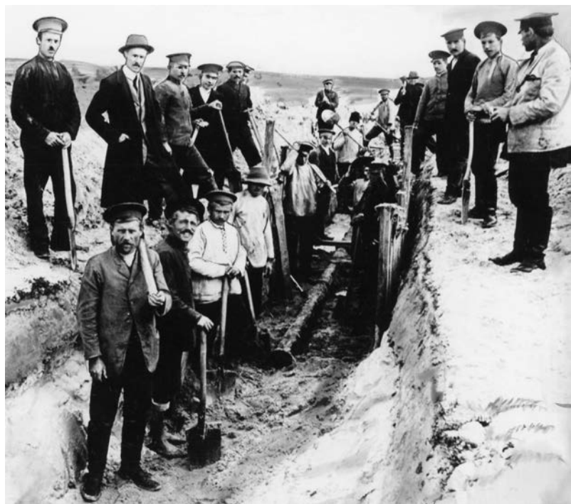
Прокладання мулопроводу від відстійників під Лисою горою до полів зневоднення
