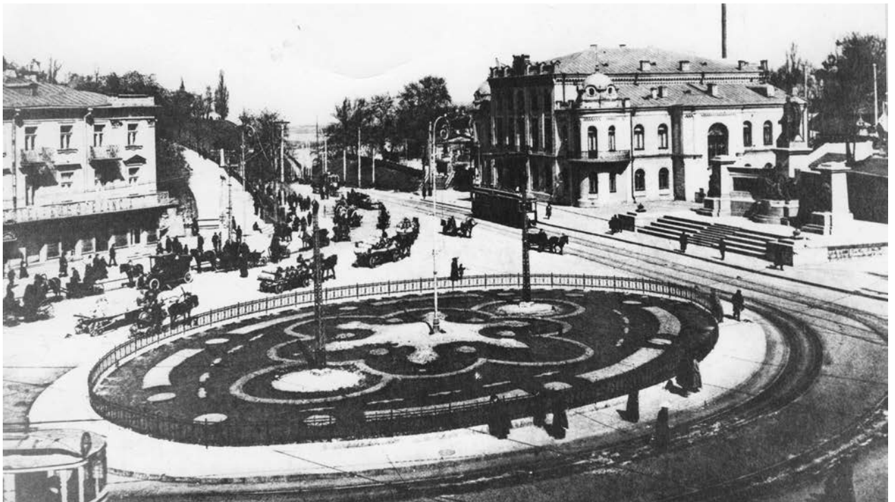
Царська площа. Під цією клумбою був головний збірний резервуар міської каналізації (1894 р.)
