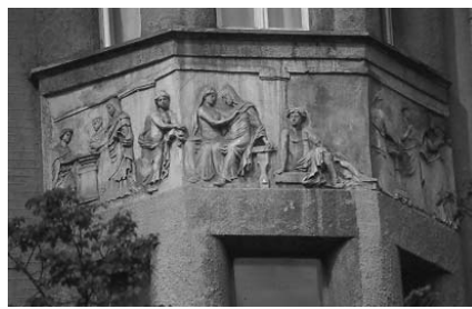
486.3. Фрагмент оздоблення еркера.
