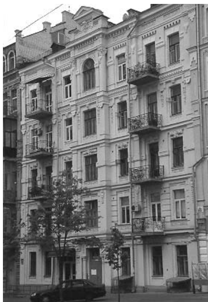
467.4. Вул. Ш. Руставелі, 36.
