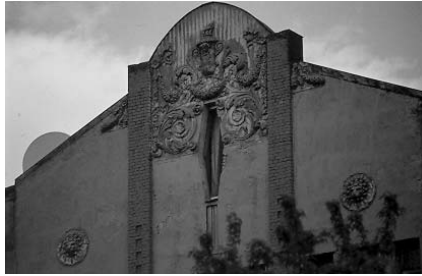
463.6. Орнаментально-декоративне завершення щипця фасаду.
