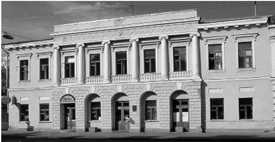
468.9. Вул. П. Сагайдачного, 20/2. Фрагмент фасаду.
