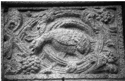
306.3. Деталі оздоблення фасаду.
