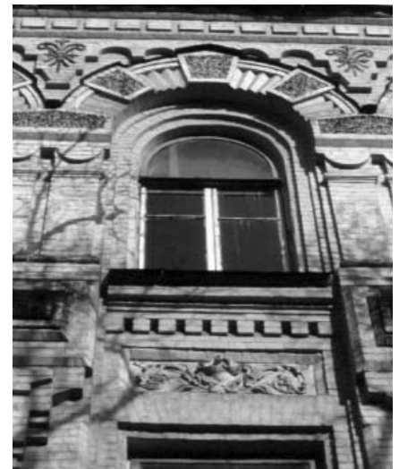
459.32. Фрагмент головного фасаду (№ 35).
