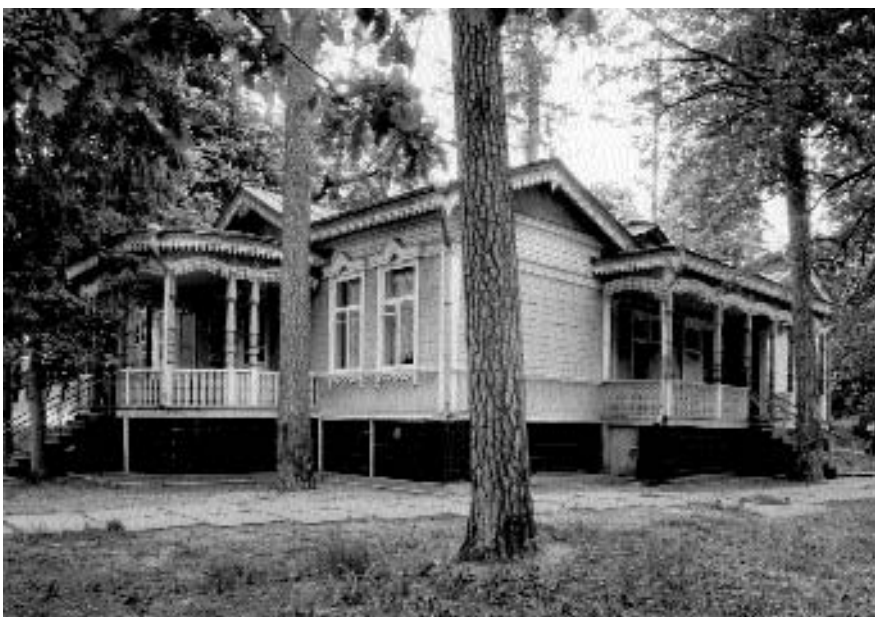
460.8. Вул. М. Юнкерова, 47.
