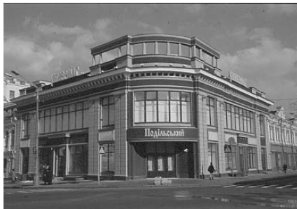
468.11. Вул. П. Сагайдачного, 24.
