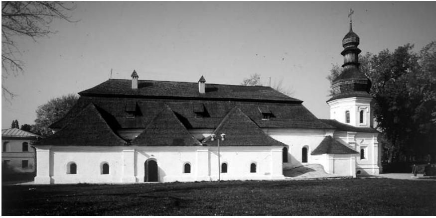
267.1.9. Трапезна з церквою св. Іоанна Богослова. Південний фасад.
