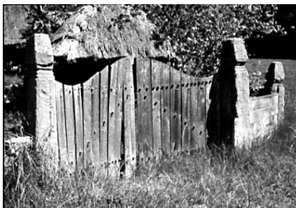
297.5.7.3. Куча — с. Гарячинці, Новоушицький р-н, Хмельницька обл., поч. 20 ст. (архит.). Однодільна, прямокутна в плані. Карка с утворюють дубові стовпи, скріплені знизу й вгорі обв'яз-
