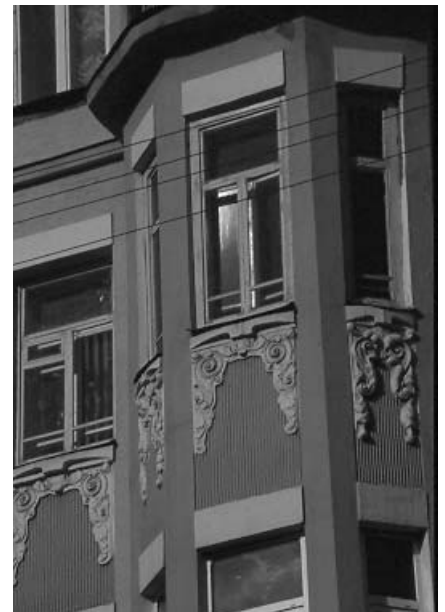
486.52. Фрагмент оздоблення еркера.
