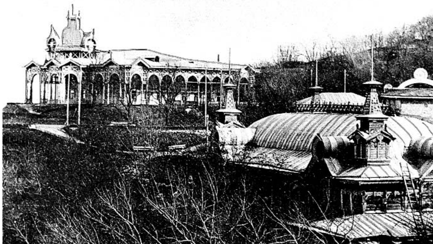
427. Фрагмент забудови. Фото 1906.
