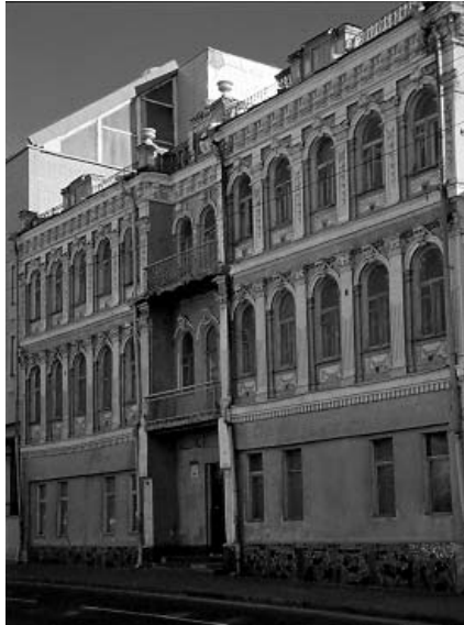
468.4. Вул. П. Сагайдачного, 19.
