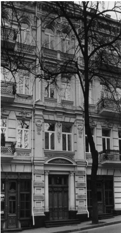
266.2. Вул. Михайлівська, 11. Фрагмент головного фасаду.
