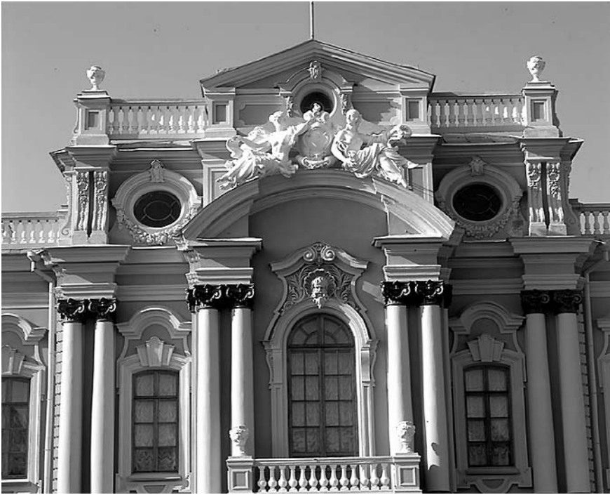
251. Фрагмент південно-східного фасаду.
