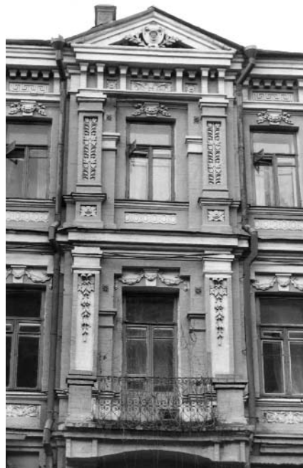
266.17. Вул. Михайлівська, 7. Фрагмент головного фасаду.
