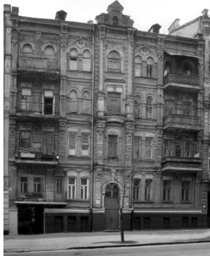
467.1. Вул. Ш. Руставелі, 32.
