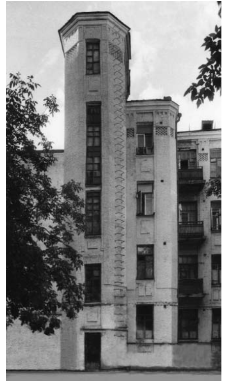
249.14. Вул. Мала Житомирська, 12-б.
