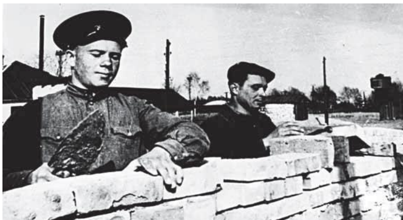
46. Кінець 1940-х рр. Спорудження житлового будинку по вул. Залізничній. Фото з музею локомотивного депо
