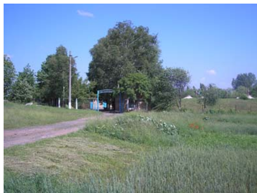
Станція другого підйому Північного водозабору
