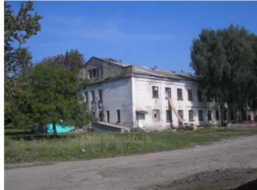
Залишки адміністративного будинку на території ліквідованої шахти № 3 “Нововолинська”
