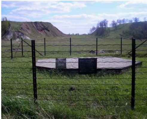
Влаштування захисної огорожі довкола клітьового ствола шахти № 3 "Нововолинська". На задньому плані – породні відвали шахти
