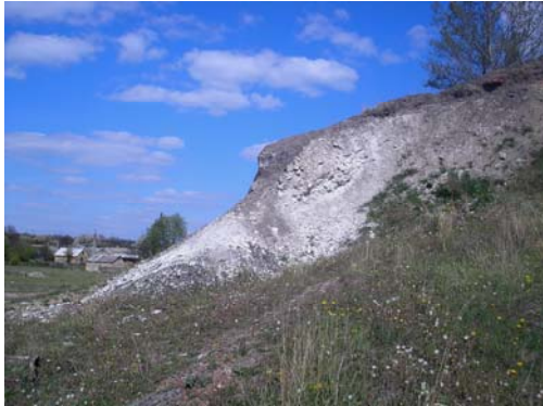
Верхньокрейдові відклади, що складають основу старого породного відвалу шахти № 3 “Нововолинська”
