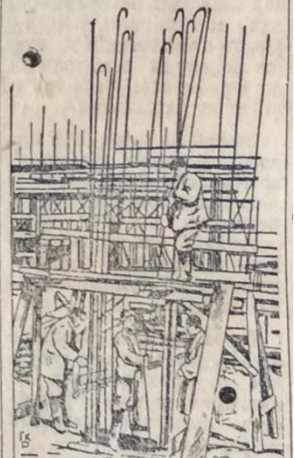
На фото: арматурники готують арматури для залівки бетону вальцювального цеху
