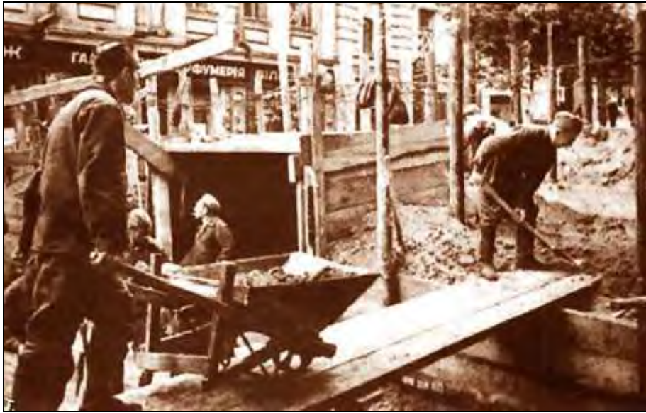
Спорудження барикади й захисного рову на вул. Лютеранській (на цих роботах були задіяні бійці народного ополчення)
