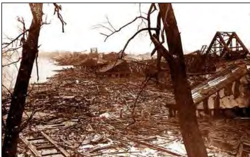
Підірваний ланцюговий міст через Дніпро
