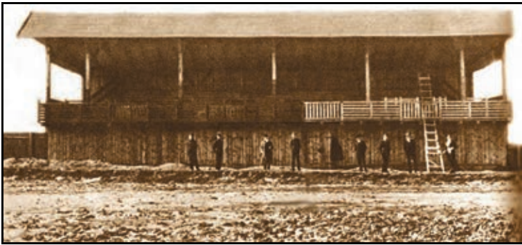
Завершення будівництва центральної трибуни нового стадіону "Погоні"
